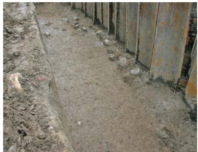
208 Faza 3b, K2. Ruševina SE 2233 na SE 2229. Pogled proti jugu.
