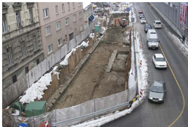
27 Izkop območjih S1 (zgoraj) in S2 (spodaj). Pogled proti severu.
