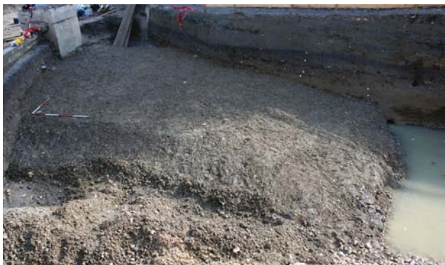
48 Faza 1b, Križišče. Pogled na naplavino SE 3228 na severovzhodnem robu struge. Pogled proti jugu.
