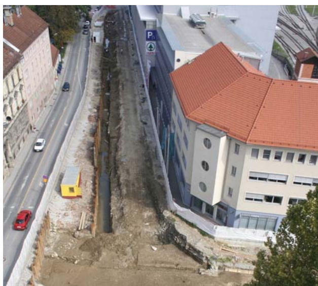
26 Izkop območja K2. Pogled proti severu.
