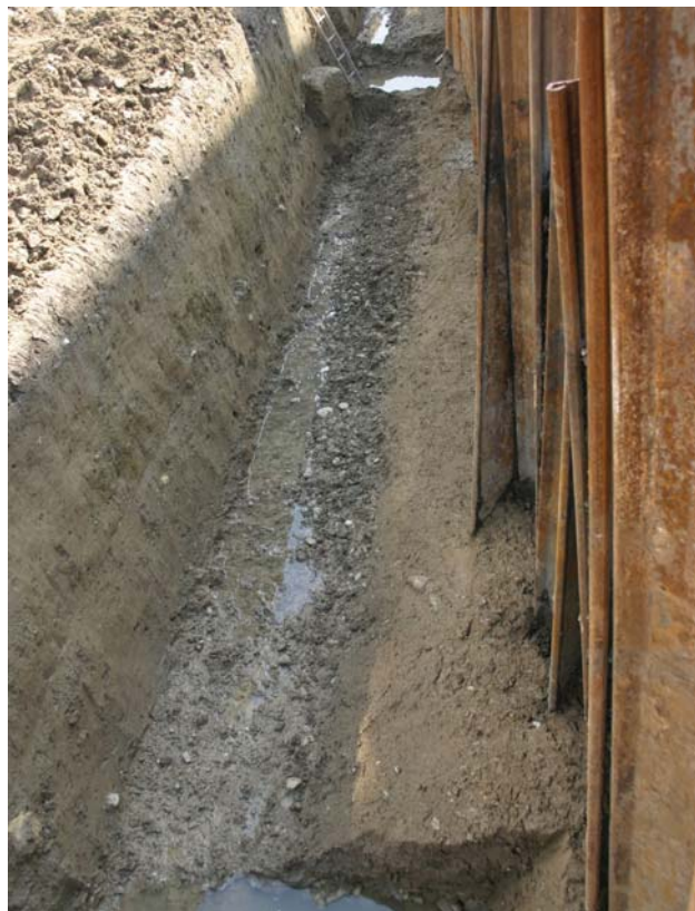
203 Faza 3b, K2. Zahodna brežina rečne struge, oblikovana s fluvialno erozijo SE 2239, vidne SE 2234–SE 2237. Pogled proti jugu.
