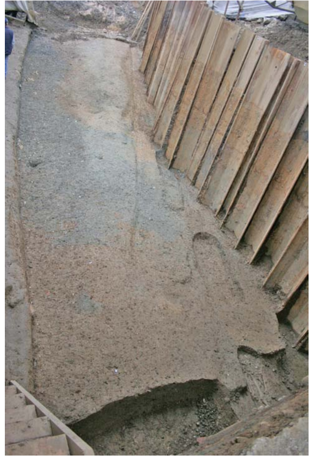
72 Faza 2a, Križišče, južno od objekta 1. SE 7019 na jugozahodni brežini. Vidni so še mlajši vkopi. Pogled proti jugu.
