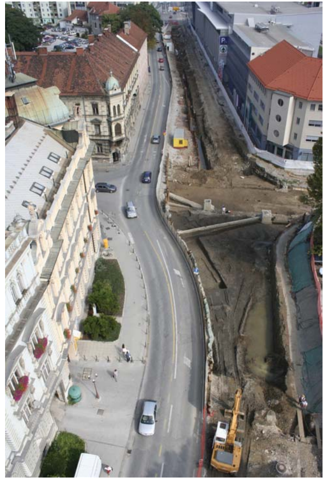
29 Izkop na območju Kanala 3. Pogled proti severu.
