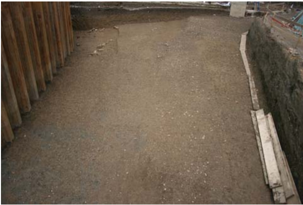
254 Faza 3c, Križišče. Naplavini SE 3262 in SE 3253. Pogled proti severu.
