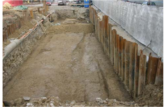
151 Faza 3a3, S2. Kolovoz (kolesnice SE 4153). Pogled proti severu.
