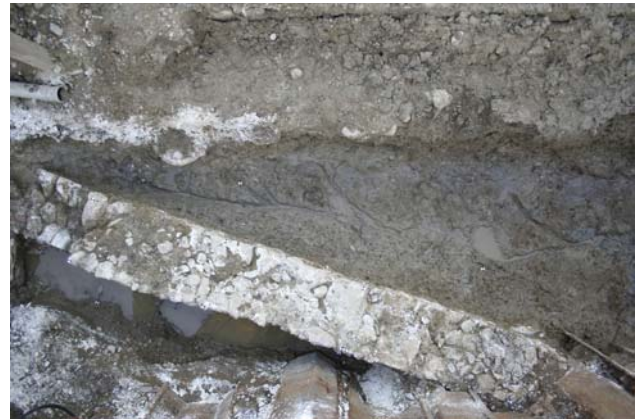
287 Faza 4a, K2. Severni podporni zid SE 2025. Pogled proti vzhodu.
