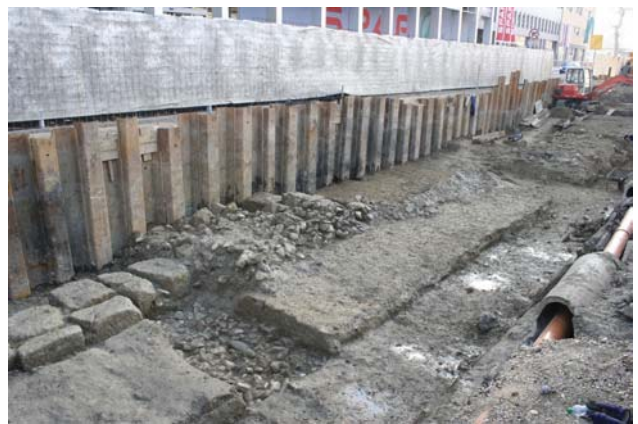
207 Faza 3b, K2, S1. Naplavina SE 4085 je segla do stolpa (SE 4007, SE 4046, SE 4063, SE 4073). Pogled proti jugovzhodu.
