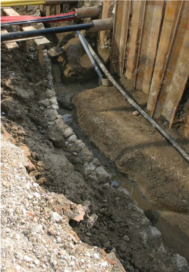
285 Faza 4a, K2. Obrambni jarek srednjeveškega dvorca SE 2188 in severni podporni zid SE 2025. Pogled proti severu.
