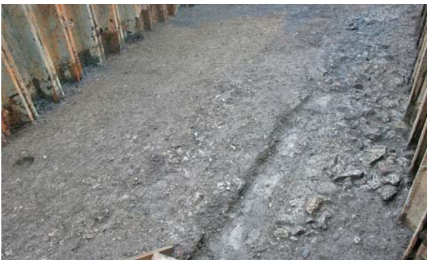
275 Faza 3d, Križišče. Ruševina SE 7005 v strugi. Pogled proti jugu.
