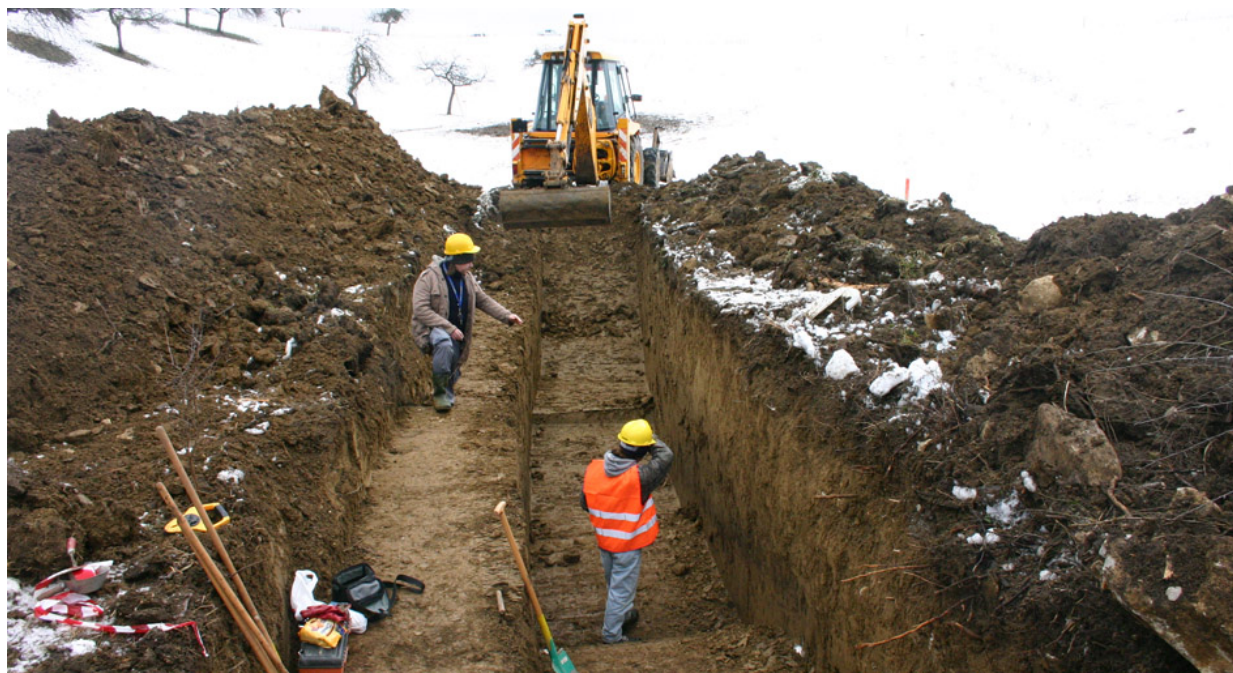
Slika 13 Izvedba strojnega izkopa testnih jarkov (arhiv ZVKDS, CPA).
