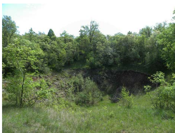
Slika 150 Izkop v vrtači št. 20, pogled proti jugovzhodu.
