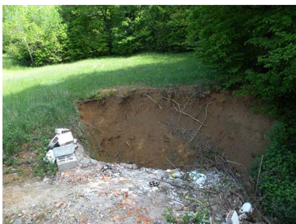
Slika 216 Vrtača št. 49, presek na severni strani izkopa.
