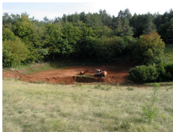
Slika 3 Izkop zemlje v vrtači pri Dobravljah.
