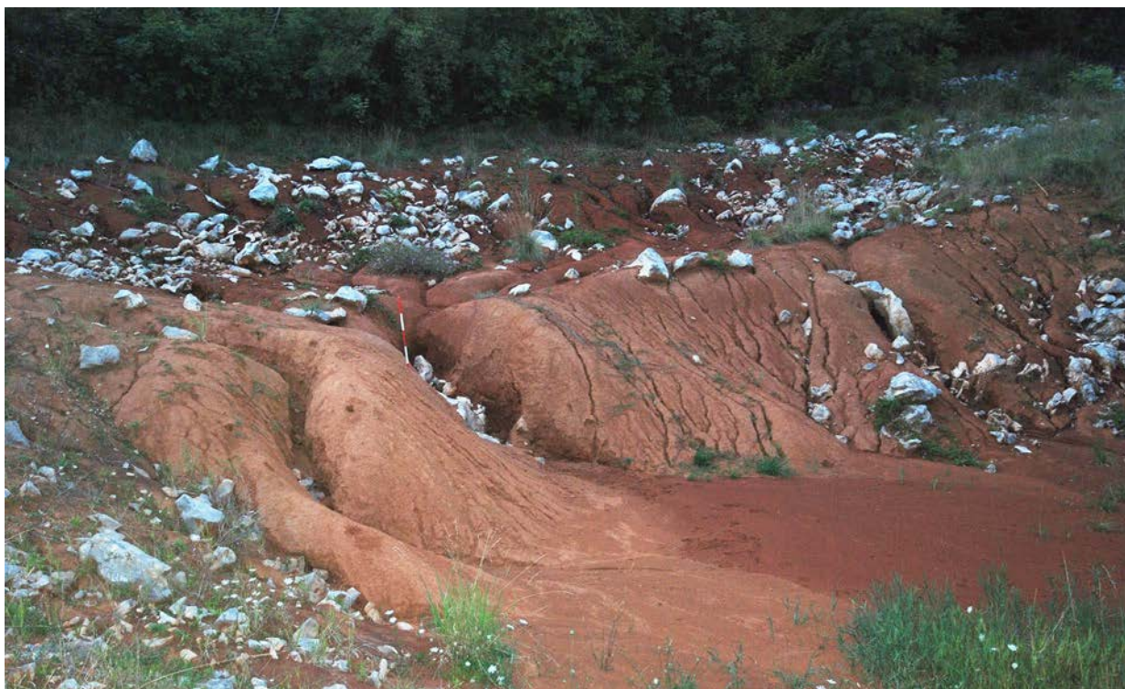
Slika 13 Učinki vodne erozije na robovih izkopa za zemljo. Avber, vrtača št. 37.
