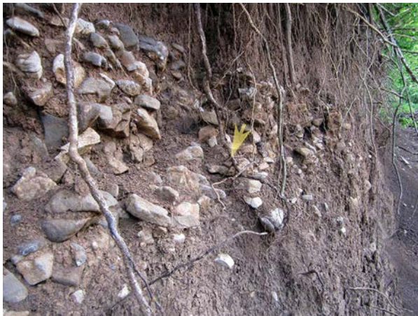
Slika 231 Plasti kamnja in meljaste ilovice na vzhodnem preseku izkopa v vrtači št. 54.
