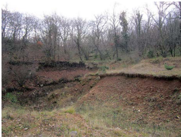
Slika 227 Izkop v vrtači št. 53, pogled proti jugovzhodu.
