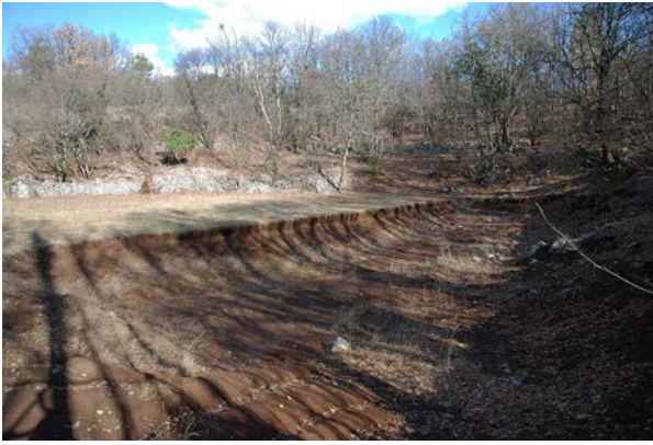
Slika 225 Izkop v vrtači št. 52, pogled proti vzhodu.
