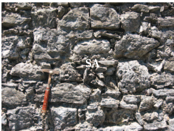
Slika 9.10: Notranje obzidje. Lomljenci so nekoliko bolje klesani, bolje se prilegajo drug drugemu. Izbira ter vgradnja blokov je tu bolj skrbna kot pri stolpu. Praznine v zidu so bile založene z manjšimi »skerilavimi« kosi apnenca (SA). Pogled 1. Blok lehnjaka (L).
