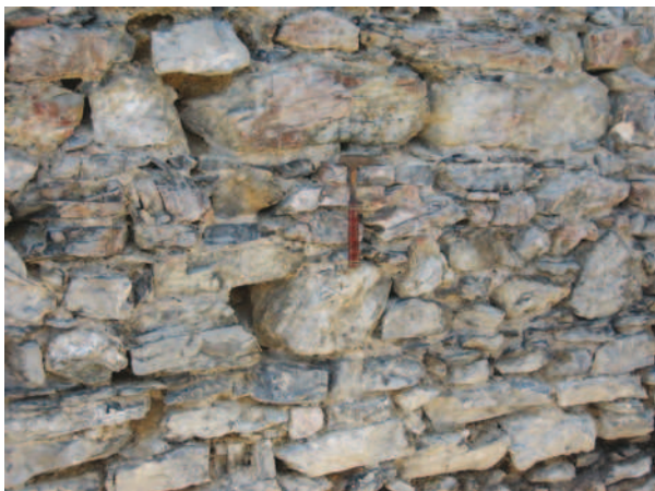
Slika 9.5: Zid v stolpu. Uporabljeni so skoraj izključno lomljenci z vrha Starega gradu. Značilno za lomljence v zidu stolpa je njihova groba oblikovanost in ne preveč skrbno zidanje, ki se kaže tudi v različni velikosti ter obliki lomljenca, torej v njihovi heterogenosti. Večinoma njihovi robovi niso klesani.
