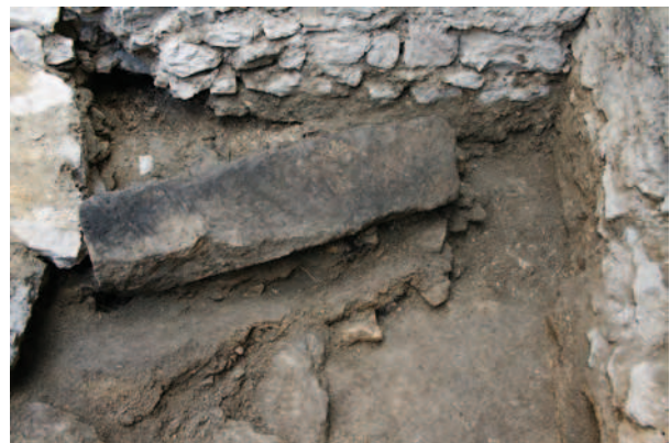
Slika 5.11: Preklada iz rumenkastega peščenjaka in situ (foto: Grega Babič).
