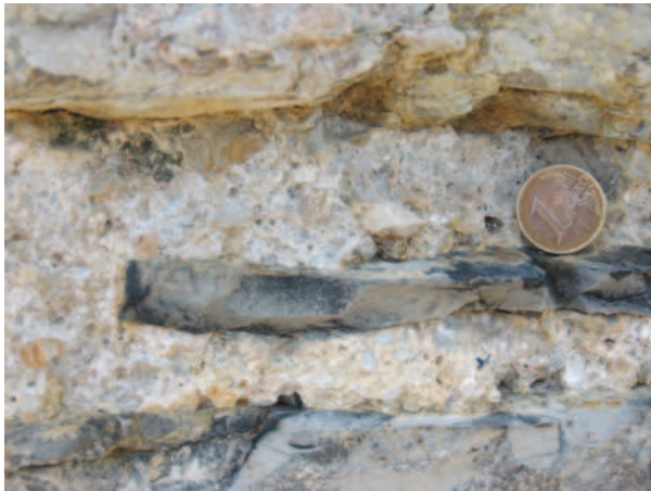
Slika 9.3: Malta pri gradnji stolpa je izdelana iz dolomitnega drobljenca in peska ter apna. Zrna drobljenca so velika do 2 cm. Pogled 1.
