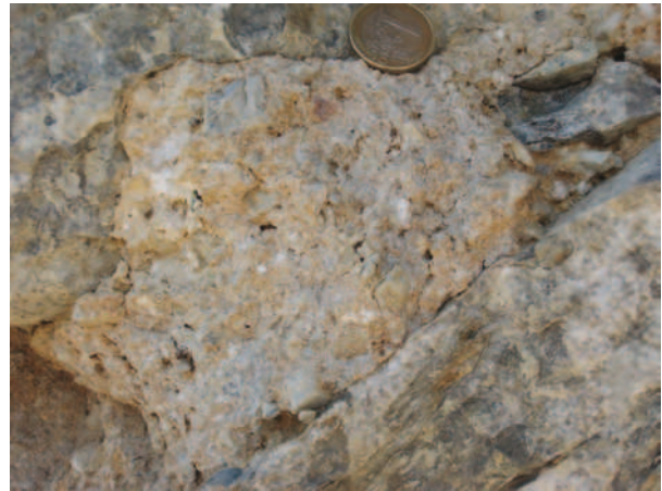
Slika 9.4: Malta pri gradnji stolpa je izdelana iz dolomitnega drobljenca in peska ter apna. Zrna drobljenca so velika do 2 cm. Pogled 2.
