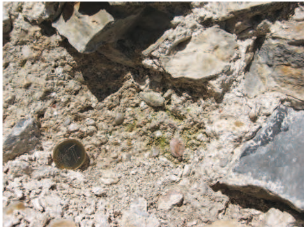
Slika 9.12: Malta v notranjem obzidju. Izdelana je iz savskega prodnatega peska in apna. Na številnih mestih se pojavljajo v malti tudi drobci opeke. Pogled 1.
