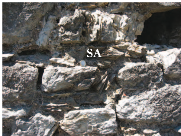
Slika 9.11: Notranje obzidje. Lomljenci so nekoliko bolje klesani, bolje se prilegajo drug drugemu. Izbira ter vgradnja blokov je tu bolj skrbna kot pri stolpu. Praznine v zidu so bile založene z manjšimi »skerilavimi« kosi apnenca (SA). Pogled 2.
