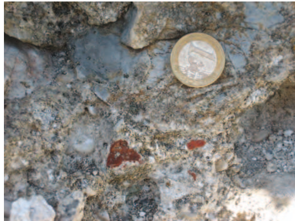
Slika 9.13: Malta v notranjem obzidju. Izdelana je iz savskega prodnatega peska in apna. Na številnih mestih se pojavljajo v malti tudi drobci opeke. Pogled 2.
