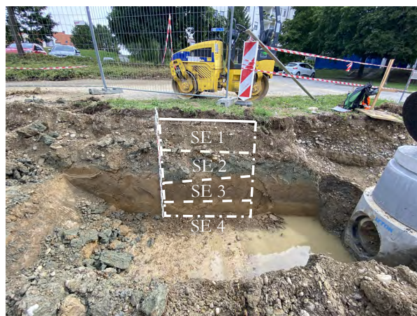
Slika 61 Presek 32; pogled proti severovzhodu.
