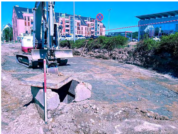
Slika 8 Pogled na območje raziskav po odstranitvi tampona ceste.
