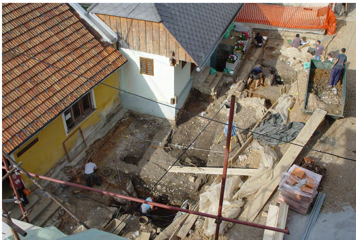
Figure/Slika 5 Črnomelj – excavation of the square in front of the Church of the Holy Spirit in 2006: the High Medieval defensive ditch (foreground) and iron working area (background) under excavation, view towards the northeast (photo by I. Pinter). / Črnomelj, izkopavanja trga pred cerkvijo sv. Duha leta 2006: izkopavanja visokosrednjeveškega obrambnega jarka (spredaj) in območja železarstva (v ozadju), pogled proti severovzhodu (foto I. Pinter).
