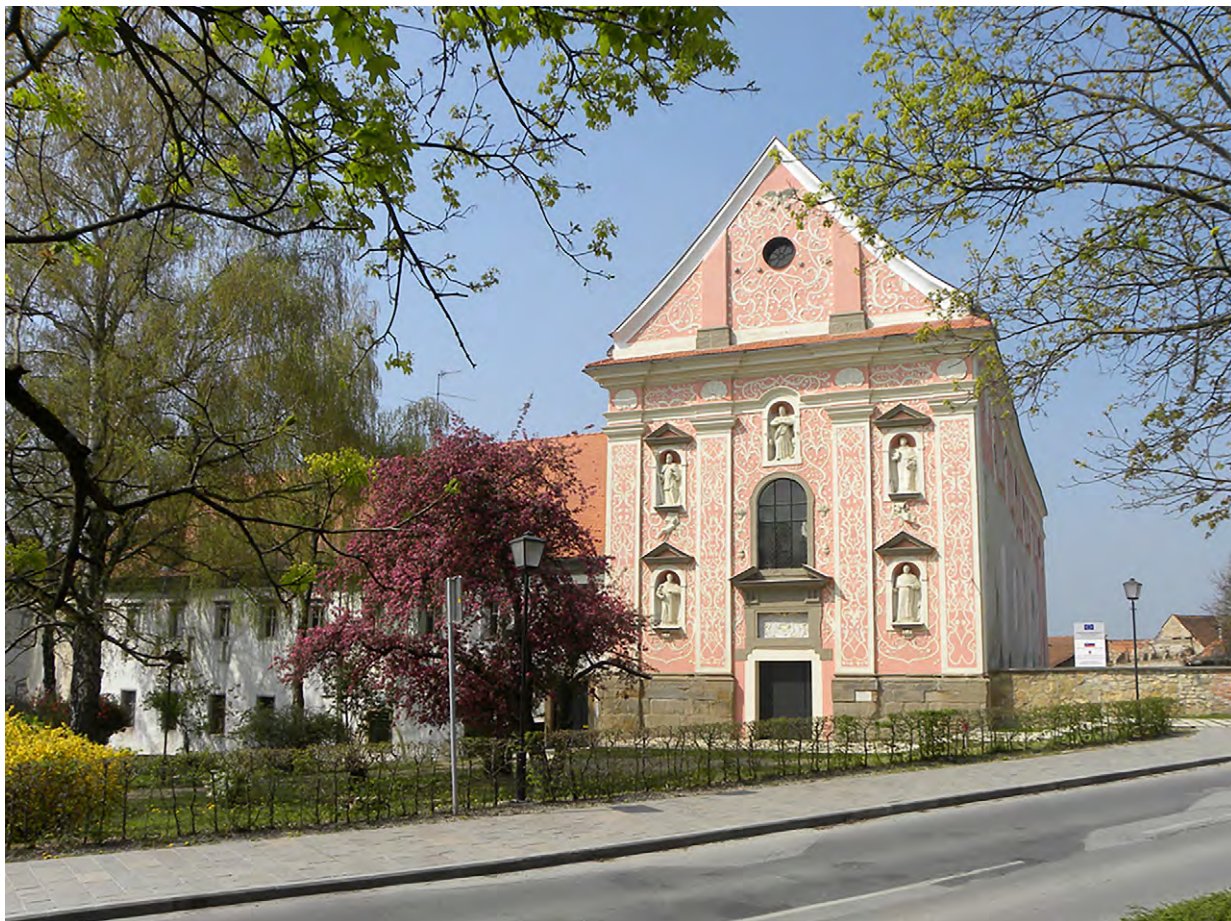
Slika/Figure 1 Dominikanski samostan na Ptuju, vzhodno pročelje baročne cerkve in vzhodnega trakta; pogled proti zahodu (foto D. Kovačič). / Dominican Monastery in Ptuj, eastern façade of the Baroque church and the east wing; view towards west (photo by D. Kovačič).
