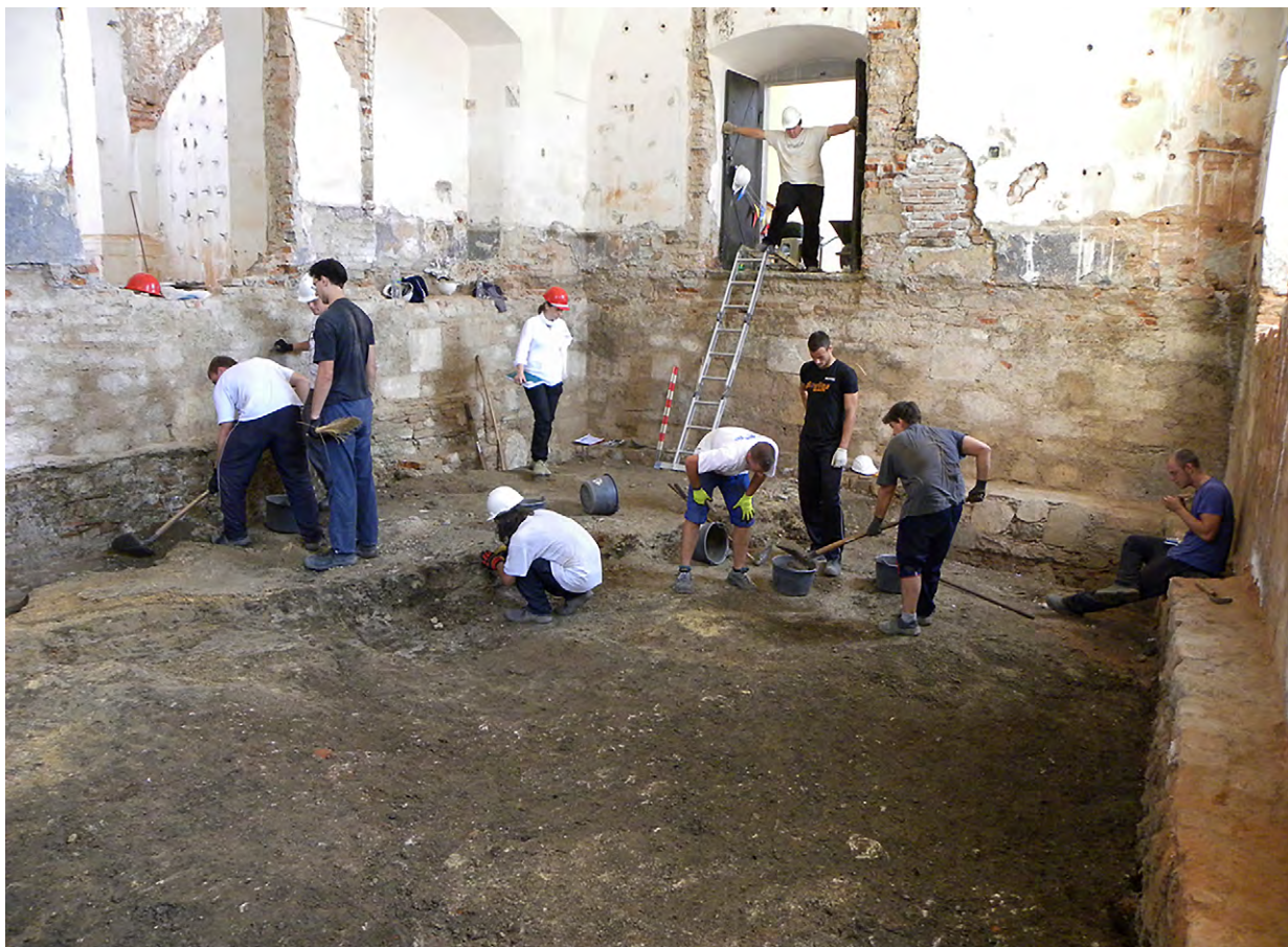
Slika/Figure 11 Stratigrafsko izkopavanje znotraj baročne zakristije (foto D. Belič). / Stratigraphic excavations inside the Baroque sacristy (photo by D. Belič).
