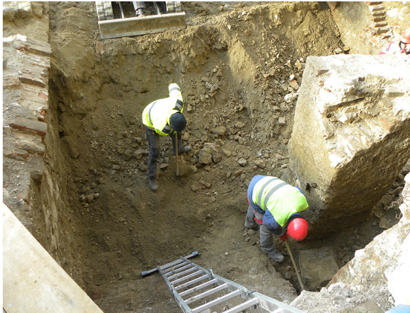
Slika 13 Strojni izkop novoveškega nasutja SE 004 in čiščenje novoveških stopnic in stebra; pogled proti zhabodu (foto E. Lazar).
