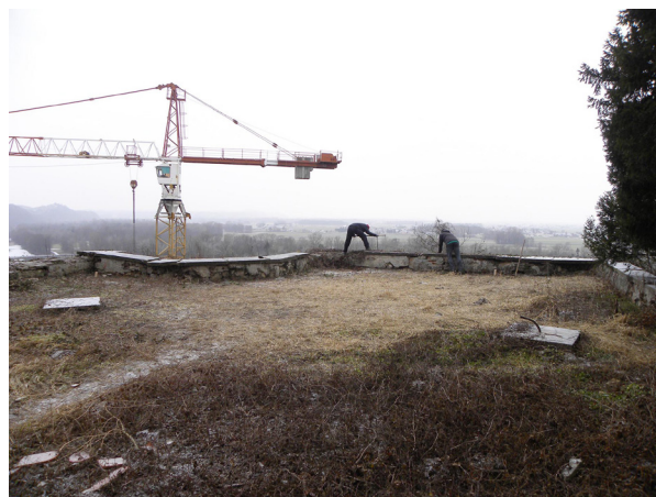
Slika 1 Območje terase pred začetkom strojnega izkopa; pogled proti zahodu (foto R. Lebar).
