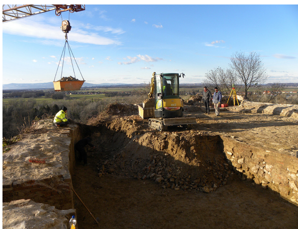
Slika 11 Strojni izkop novoveškega nasutja SE 003 iz južnega dela kleti; pogled proti jugozahodu (foto E. Lazar).
