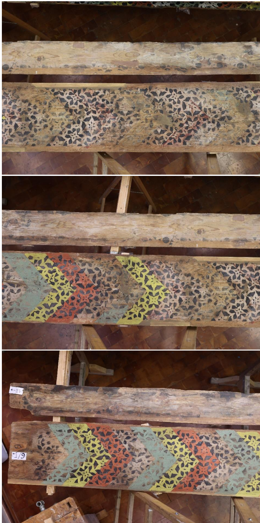
Slike 11, 12 in 13 - stanje poslikave pred posegi, med posegi in po posegih (foto Vito in Rok Dolničar)
