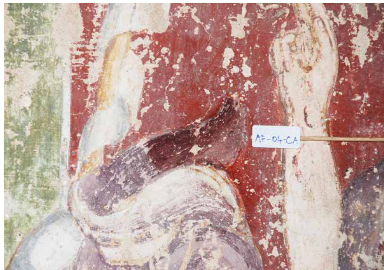
Foto 2: Parete sud, prove di coesione tramite tamponcini di cotone inumiditi di acqua (foto: Alberto Felici, 2021). Fig. 2: South wall, cohesion tests using cotton swabs moistened with water (photo: Alberto Felici, 2021).
