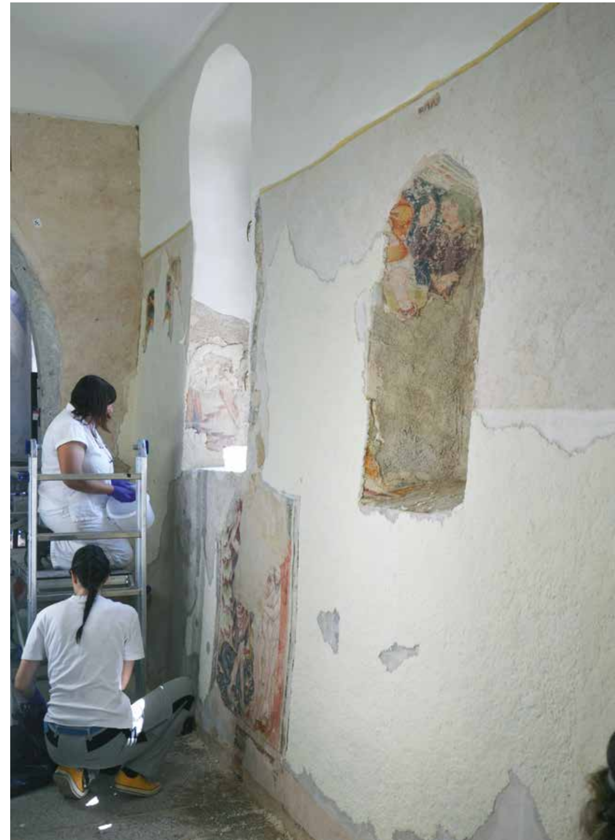
Slika 9: Nanašanje obloge z barijevim hidroksidom (foto: Andrej Jazbec, 2023). Fig. 9: Applying a barium hydroxide poultice (photo: Andrej Jazbec, 2023).
