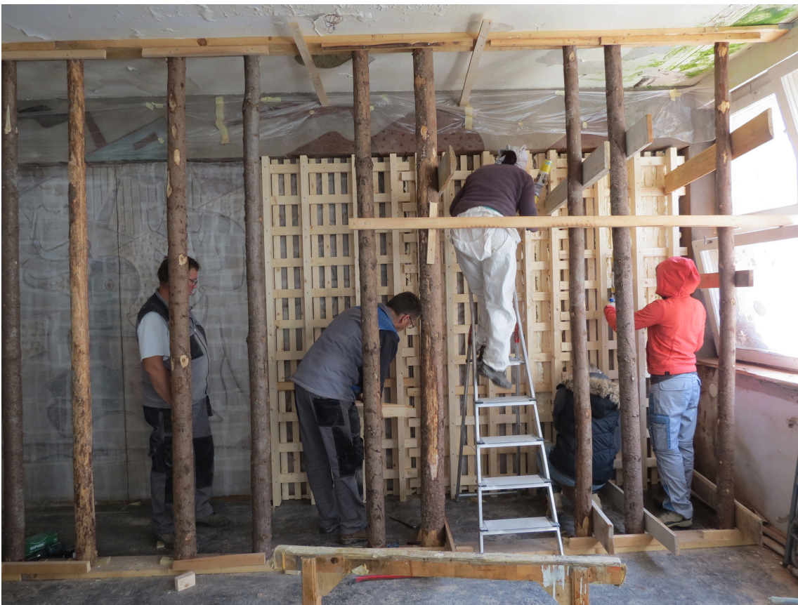
Montaža zaščitne konstrukcije, foto arhiv ZVKDS.
