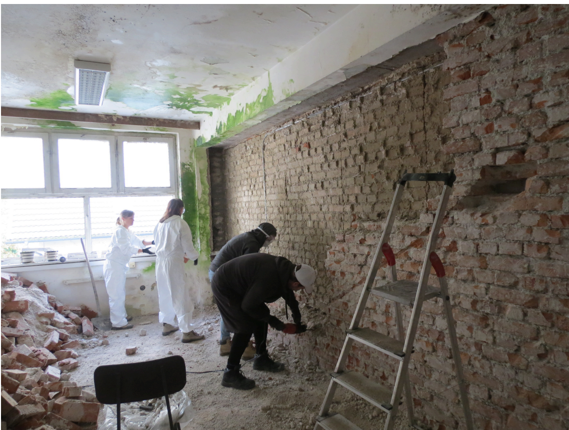
Odstranjevanje opečnatega nosilca, foto arhiv ZVKDS.
