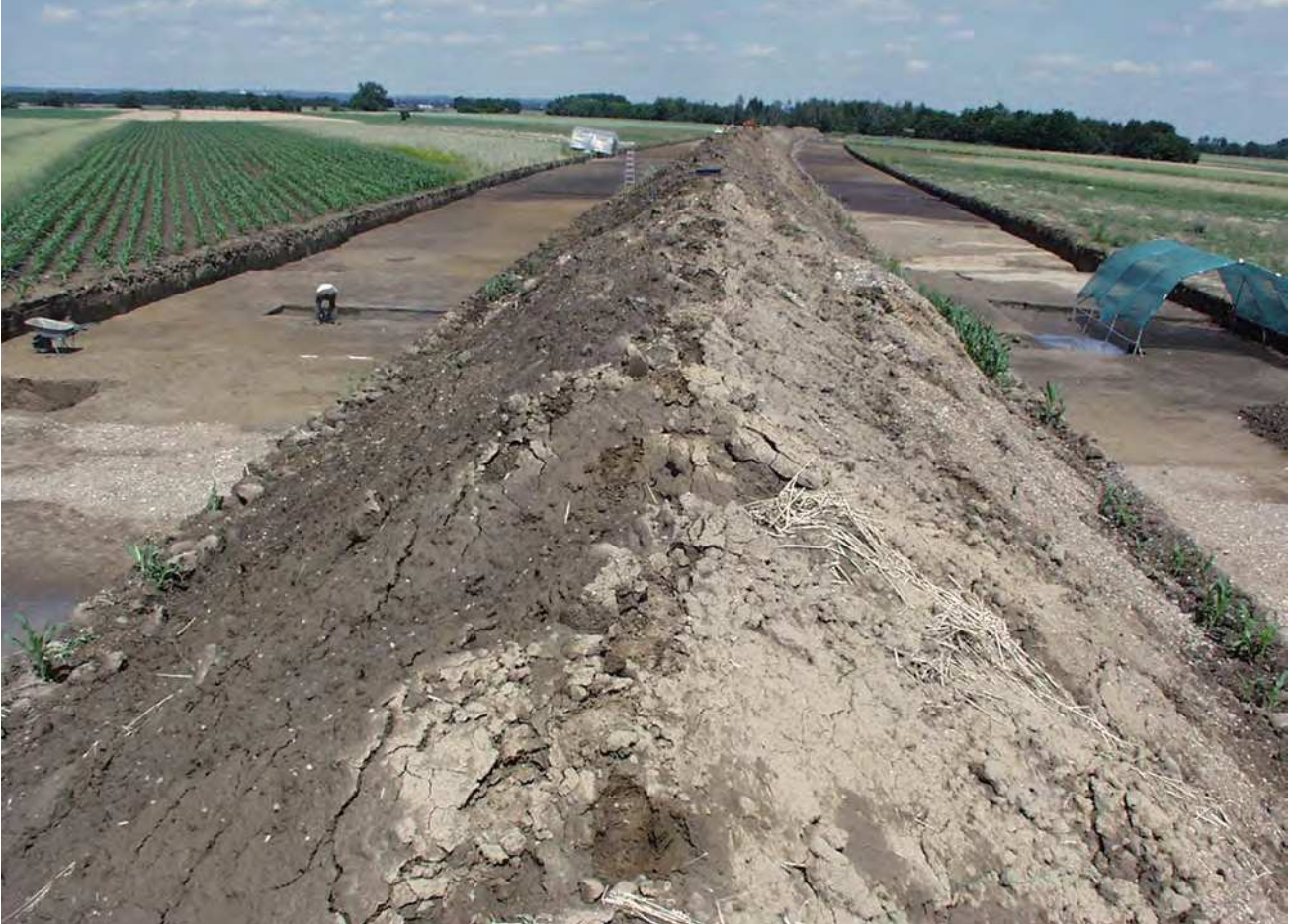
4 Pogled na izkopano traso na najdišču s kupom izkopane zemlje med izkopnima poljema, pogled s severa.
