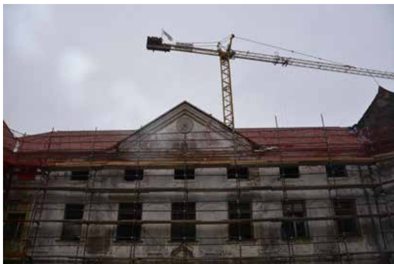
Slika 1: Obnova strehe na severnem grajskem traktu v letu 2024 (Foto: Bojan Zaletelj, 2024)
