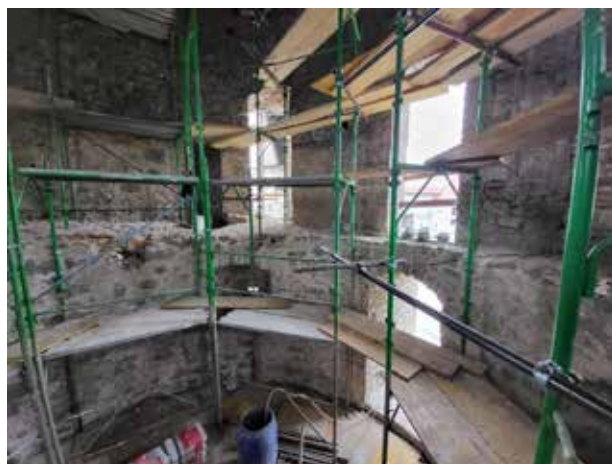
Slika 2: Prenova notranjega plašča stolpa št. 3 (Foto: Tomaž Golob)
