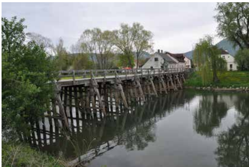
Slika 1: Severni most pred sanacijo (Foto: Judita Podgornik Zaletelj)
