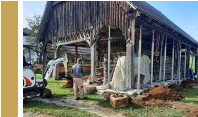
Slika 1: Plutov skedenj med obnovo. Izvedba točkovnih temeljev za nosilne stebre obeh prislonjenih kozolcev leta 2022 (Foto: Dušan Štepec)
