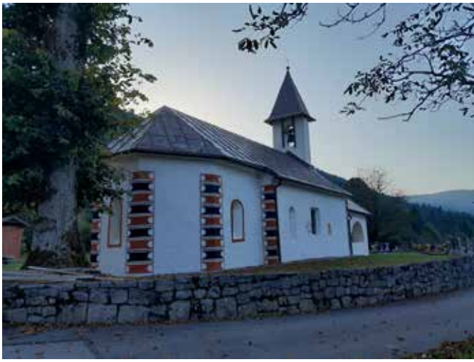
Slika 1: Pogled na obnovljeno fasado cerkve z jugovzhoda (Foto: Mateja Ocepek)
