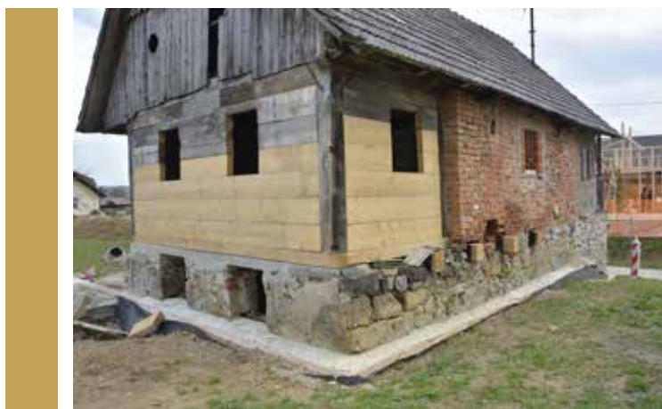
Slika 2: Hiša po zamenjavi dotrajanih lesenih delov stropne konstrukcije in lesenih sten (Foto: Dušan Štepec)
