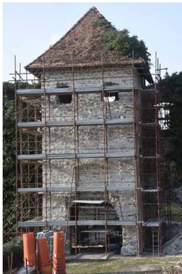
Slika 2: Prenova zunanjega plašča na vhodnem stolpu v letu 2024 (Foto: Bojan Zaletelj)
