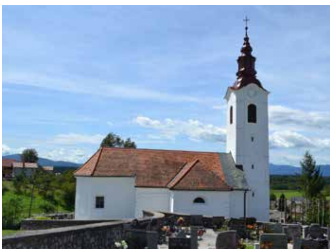
Slika 2: Cerkev v Smolenji vasi po obnovi fasade (Foto: Ana Krevelj)
