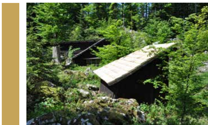
Slika 3: Nova streha na skladišču (Foto: Judita Podgornik Zaletelj)
