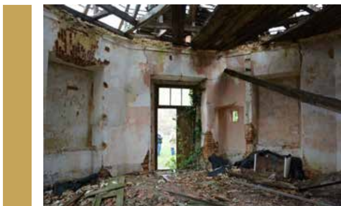
Sliki 3 in 4: Ometi v notranjosti so dotrajani zaradi propadle strehe. (Foto: Tanja Mesojedec)
