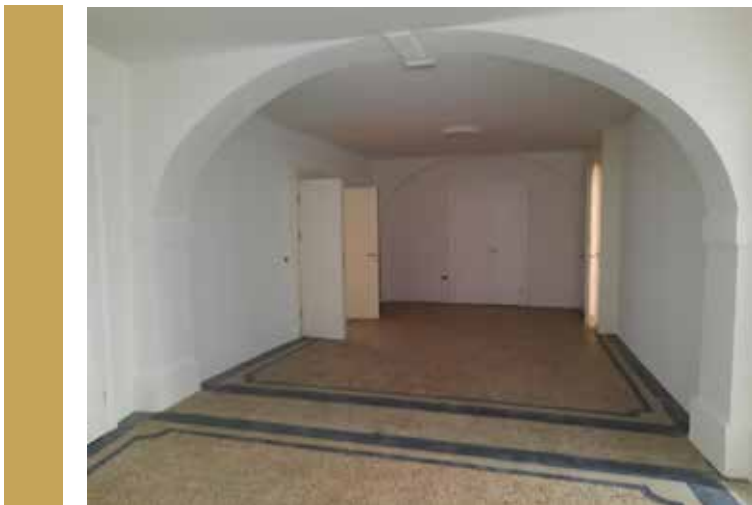
Slika 1: Hodnik z obnovljenim teracom in novimi požarnimi vrati (Foto: Tomaž Golob)
