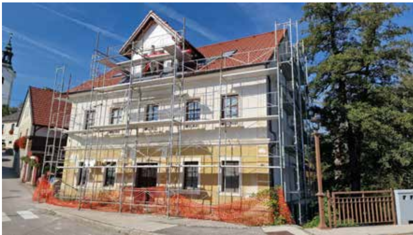
Slika 3: Hiša med obnovo (Foto: Dušan Štepec)
