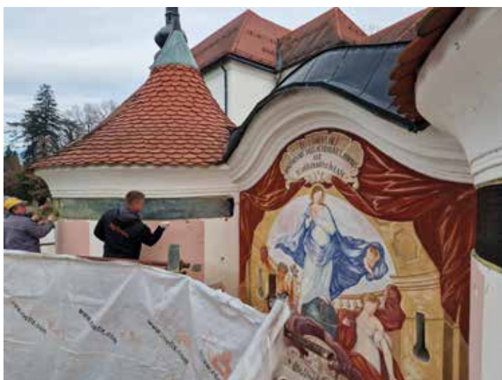
Slika 1: Vgradnja karbonskih vezi (Foto: Gip Kodrič, d. o. o.)
