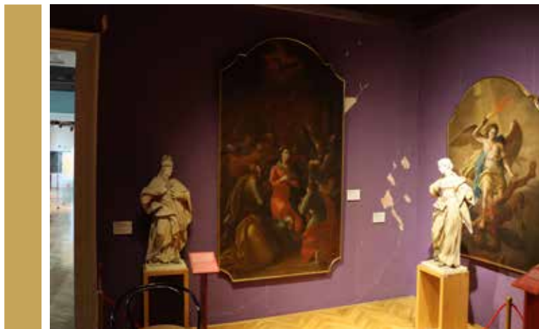
Slika 1: Razpokane stene po potresu na Hrvaškem (Foto: Posavski muzej Brežice)
