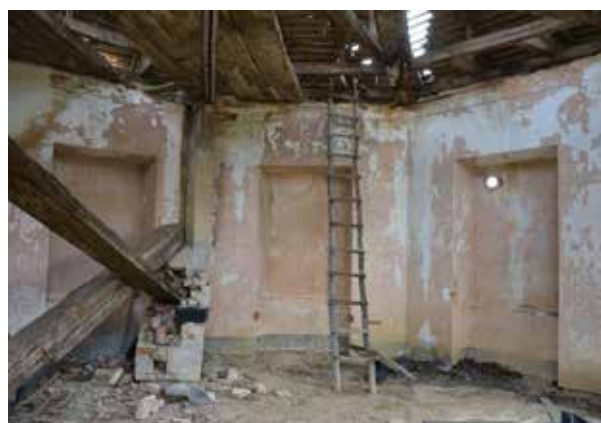
Sliki 3 in 4: Ometi v notranjosti so dotrajani zaradi propadle strehe. (Foto: Tanja Mesojedec)
