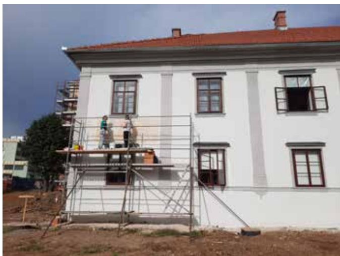
Slika 1: Restavriranje freske na vzhodnem pročelju dvorca Mostek (Foto: Tomaž Golob)
