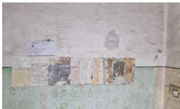
Slika 2: Stratigrafska raziskava opleska (Foto: Tanja Mesojedec)
