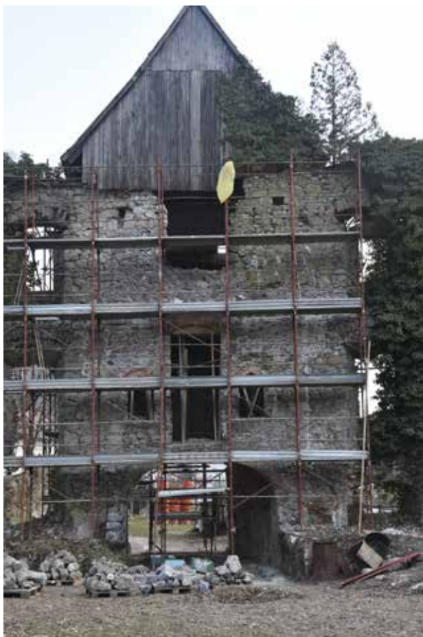
Slika 1: Dvoriščno pročelje vhodnega stolpa z rekonstruiranimi okenskimi in vratnimi odprtinami leta 2024 (Foto: Bojan Zaletelj)
