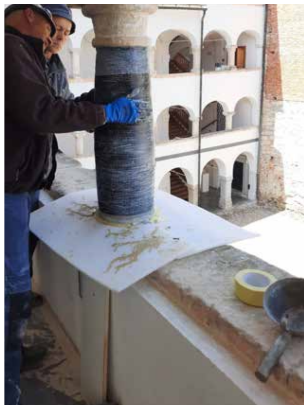
Slika 2: Sanacija kamnitega stebra v arkadnem hodniku (Foto: Bojan Zaletelj)
