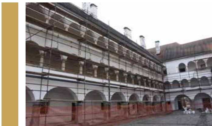
Slika 1: Popotresna sanacija južnega arkadnega hodnika v nekdanjem samostanu v Kostanjevici (Foto: Bojan Zaletelj)
