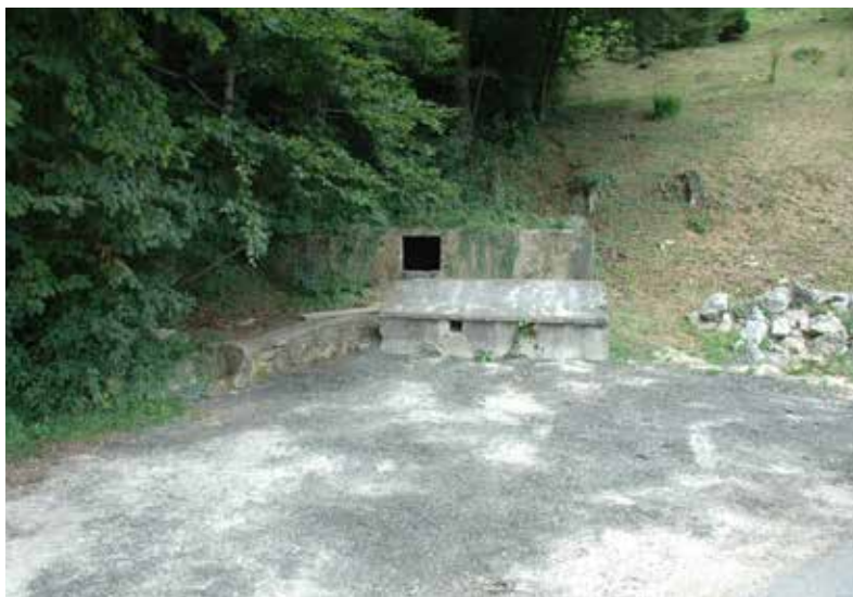
Slika 1: Stanje leta 2010 pred obnovo (Foto: Dušan Štepec)
