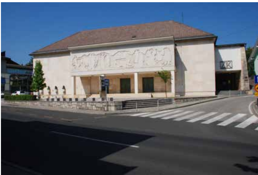
Slika 1: Kulturni dom Črnomelj – pogled na cestno fasado (Foto: Judita Podgornik Zaletelj)
