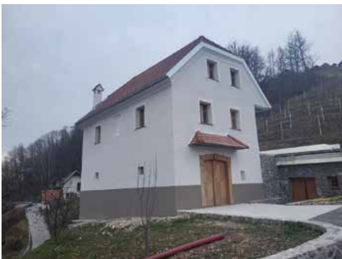
Slika 2: Obnovljena zidanica (Foto: Dušan Štepec)
