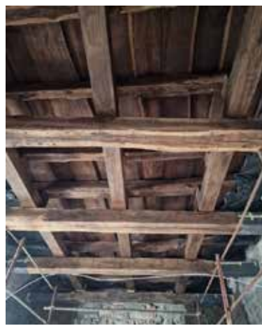
Slika 2: Očiščena stropna konstrukcija v veliki dvorani (Foto: Mojca Verček Rems)
