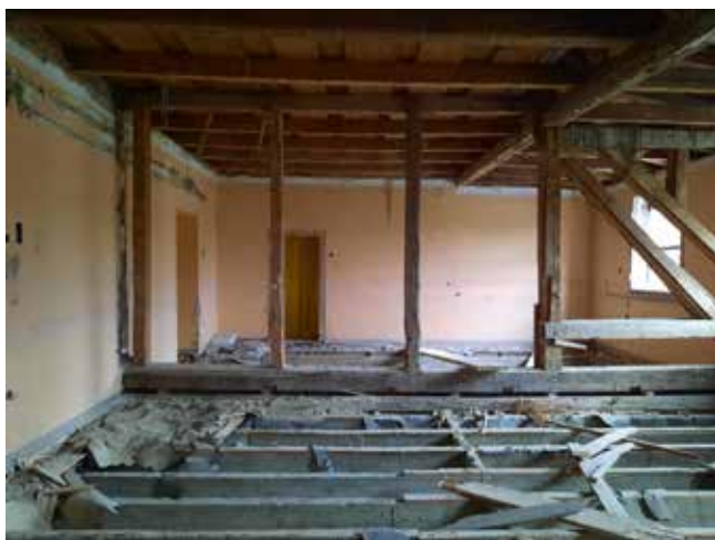
Slika 1: Dotrajane povojne stropne konstrukcije iz betonskih gred, na katere je bila vgrajena lesena obloga z ometom na trstiko, so zamenjane z novimi souprežnimi stropi. (Foto: Tomaž Golob)
