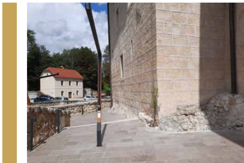
Slika 2: Detajl prenovljene grajske terase z novim kamnitim tlakom, parapetno osvetlitvijo in stojalom za senčnik (Foto: Tomaž Golob)
