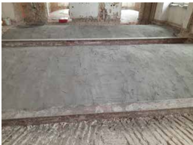
Slika 2: Opečne obočne konstrukcije so bile statično sanirane z visoko duktilno, dvokomponentno, mikroarmirano malto na osnovi veziv s pucolansko reakcijo po tehnologiji Planitop HDM s steklenimi mrežicami in sidri fiocco podjetja Mapei. (Foto: Tomaž Golob)
