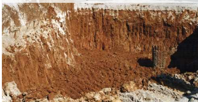
234 Gradbena jama za postavitve novega nadvoza čez bodočo avtocesto, tik ob starem nadvozu. V vrtinah na tej lokaciji je dokazano, da so rdeča kraška tla debela kar 13m. Ta lokacija se nahaja okoli 100m vzhodno od razkopa na Rogovili.
