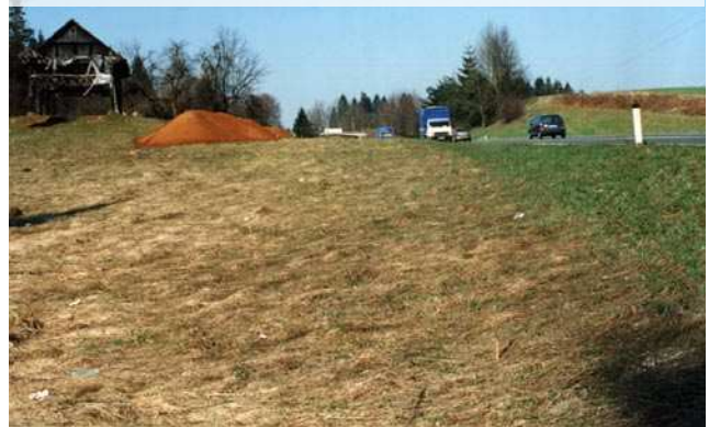
232 Vzpetina s kozolcem toplarjem na južni strani magistralne ceste LJ–ZG se nadaljuje preko ceste na severno stran. Cesta jo je prerezala na dva dela. Pogled proti zahodu.
