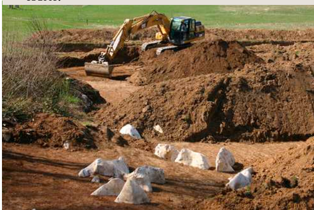
31 Odstranjevanje plasti SE 1001 v zahodnem delu izkopnega polja; v ospredju izdanki apnenčaste kamnite podlage na površini plasti SE 1003.
