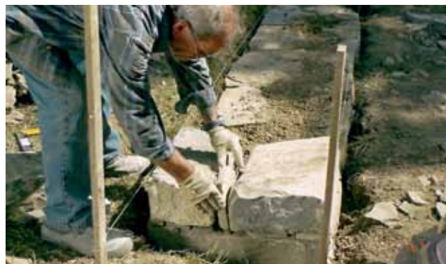
Vstavljanje manjših kamnov/ Umetanje manjih kamenova
