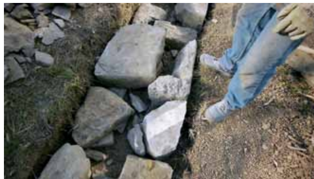
Peta (temelj) zida/ Peta (temelj) zida
