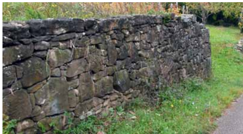
Podporni zid v okolici Krkavč/Škarpa u okolici Krkavča
