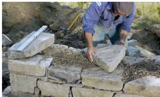
Polaganje robnega kamna/ Postavljanje rubnoga kamena
