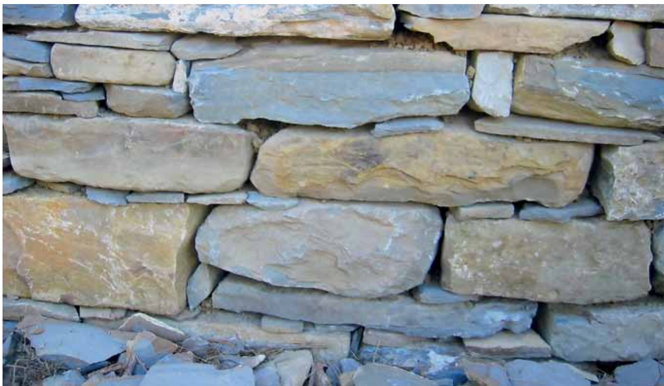
Lice zida, zgrajenega na drugi delavnici v Pisarih/Čelo zida, izgrađenog na drugoj radionici u Pisarima
