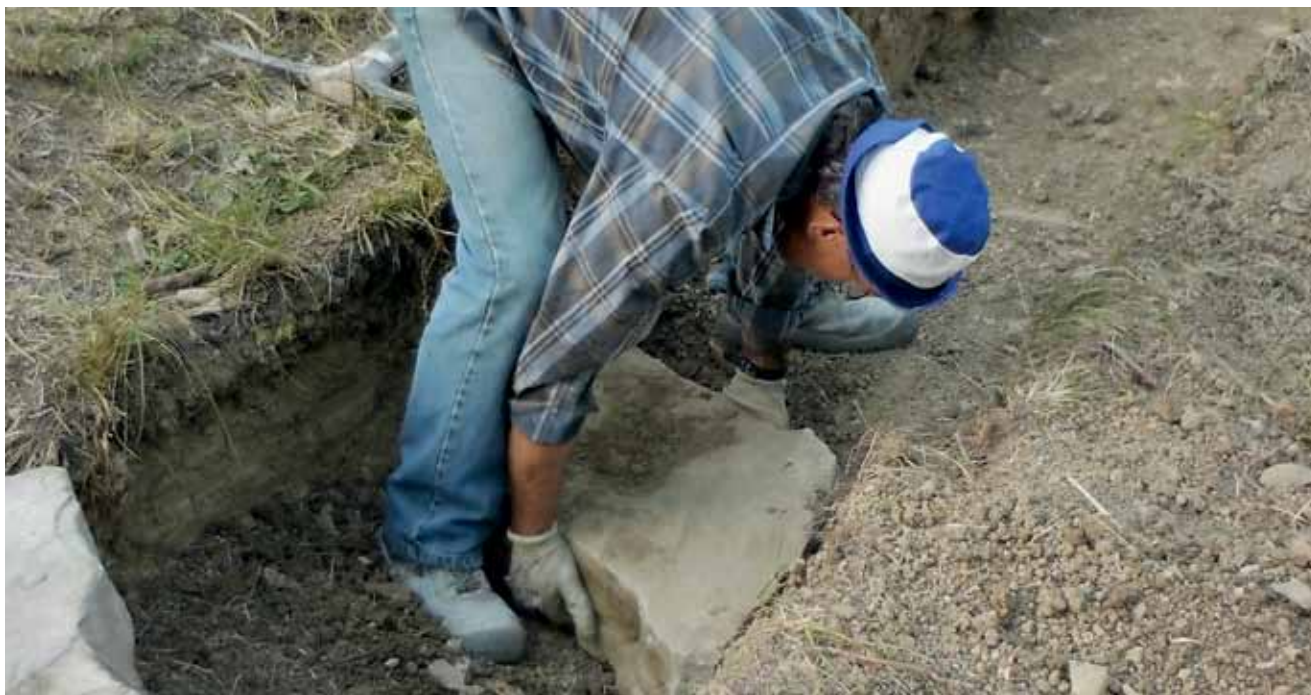
Izdelava pete (temelja) zida/Izrada pete (temelja) zida
