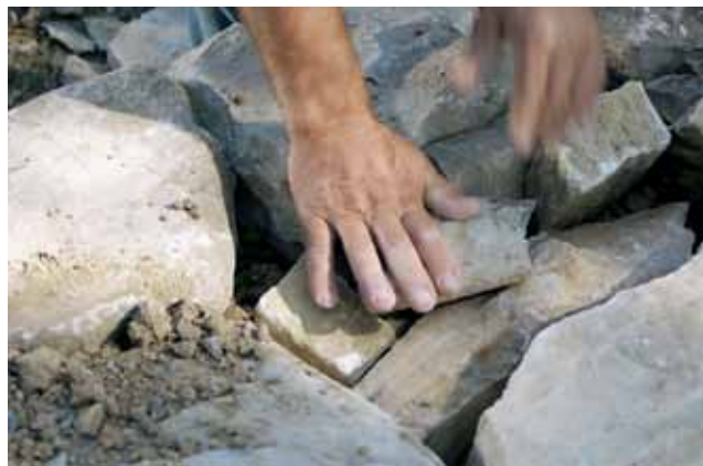
Zapolnjevanje notranjosti zidu z drobirjem/ Ispunjavanje unutrašnjosti zida sipinom
