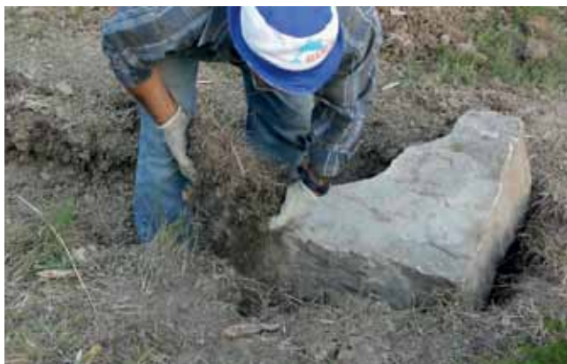
Polaganje temelja vogala/Polaganje temelja ugla
