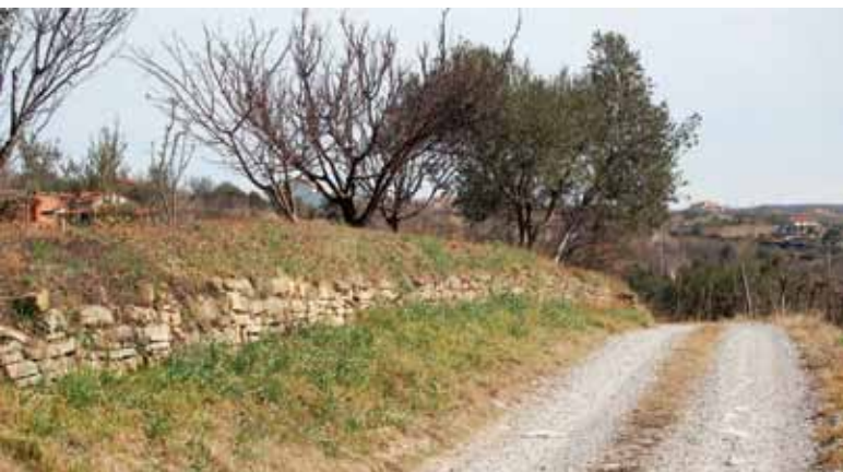
Podporni zid ob poti v Strunjanu/ Podporni zid uz put u Strunjanu
