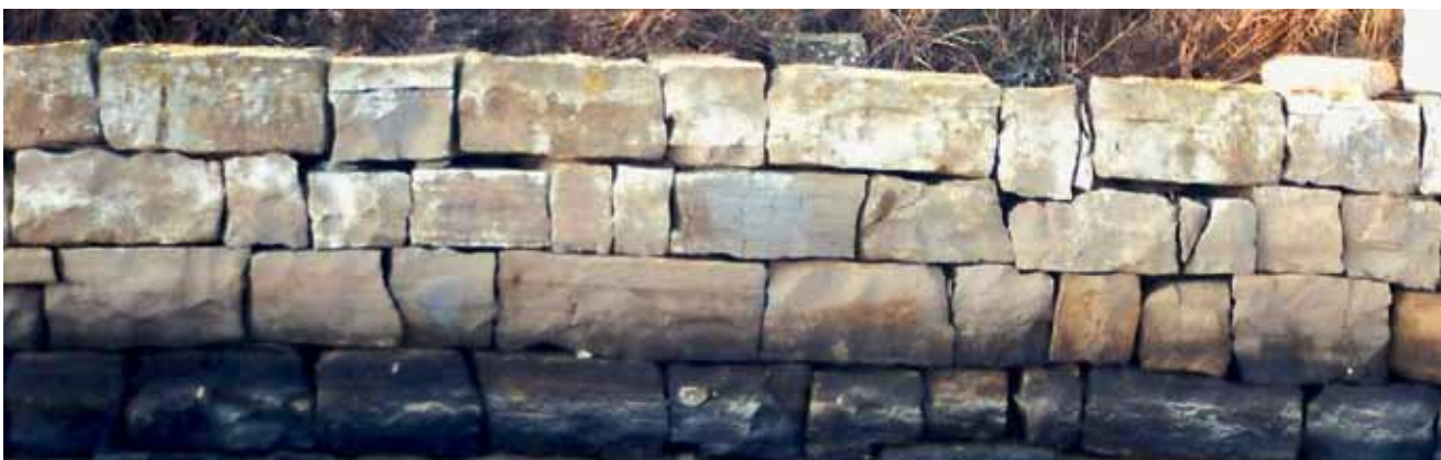
Podporni zid brega kanala v Sečoveljskih solinah/ Potporni zid obale kanala u Sečoveljskim solinama
