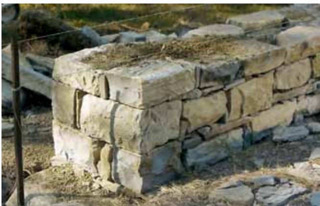
Pravilno zgrajen vogal/Pravilno izgrađen ugao
