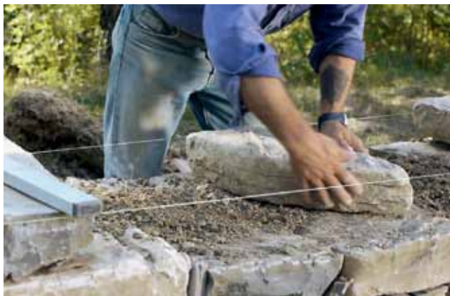
Polaganje veznega kamna/ Polaganje veznog kamena
