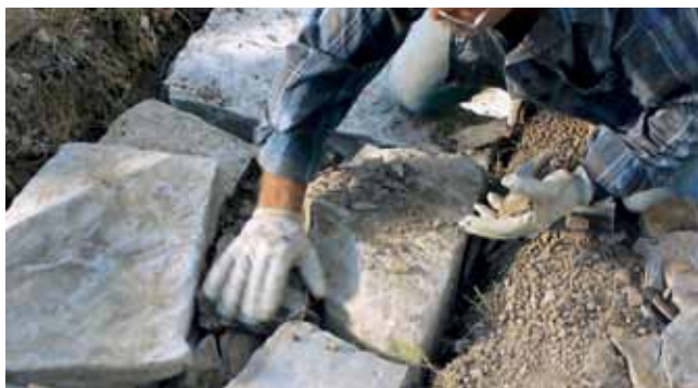
Zapolnjevanje temelja z drobirjem/ Zapunjavanje temelja sipinom
