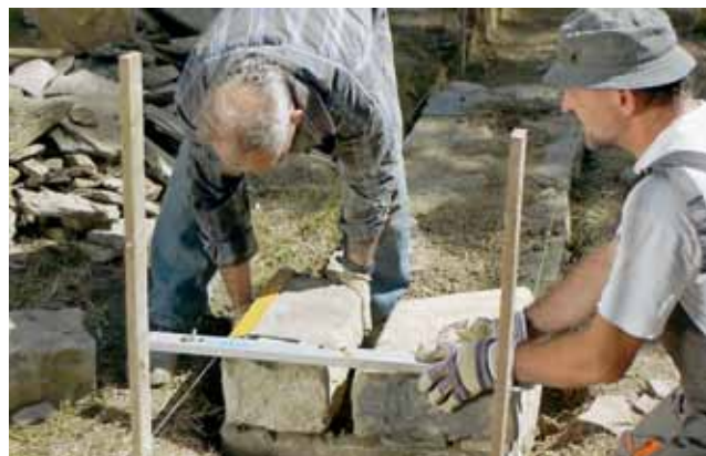
Gradnja vogala/Gradnja ugla
