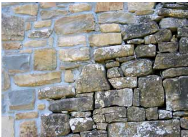
Očitna razlika med starim in novim zidom v Laborju in Maliji/ Očita razlika između starog i novog zida u Laboru i Maliji
