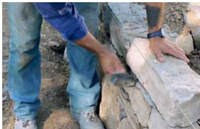
Postavljanje robnega kamna/ Polaganje rubnog kamena
