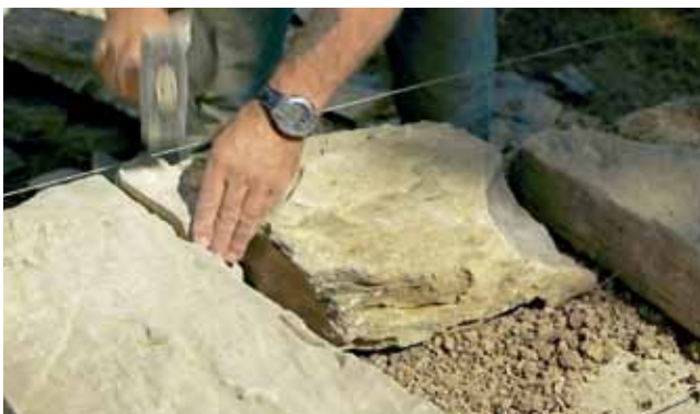
Vstavljanje manjših kamnov/ Umetanje manjih kamenova
