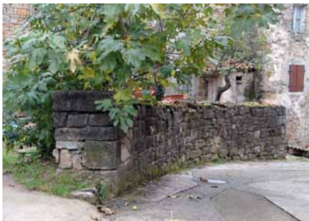
Dvorišni zid v Novi Vasi/Dvorišni zid u Novoj Vasi
