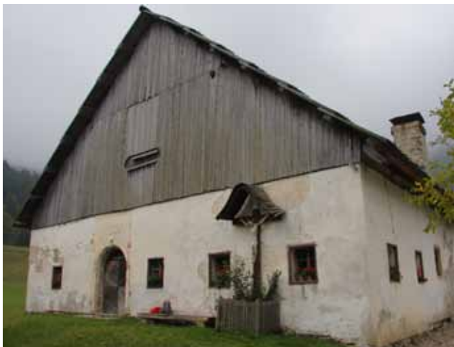
Slika/Abbildung 56: Lesen zatrep, jasno ločen od ostale fasade / Giebel aus Holz, klar getrennt von der restlichen Fassade (Zgornje Jezersko)
