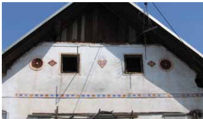
Slika/Abbildung 68: Kamniti okenski okvirji, opečnate rozete v zatrepu, profiliran pas, poslikan z rdečimi in modrimi rombi, ki ločuje zatrep od ostalega dela fasade / Fensterrahmen aus Stein, Ziegelrosette im Giebel, profilierter Gürtel, bemalt mit roten und blauen Rauten, welcher den Giebel vom restlichen Teil der Fassade trennt (Leše pri Trziču)
