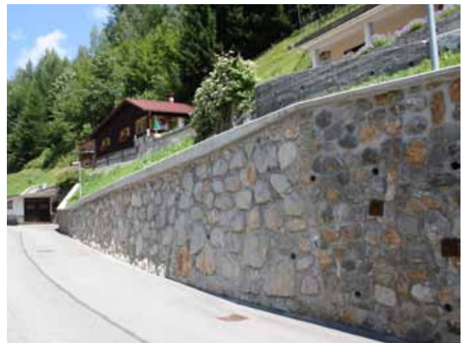
Slika/Abbildung 67: Kamnita škarpa s širokimi fugami med kamni / Stützmauer aus Stein mit breiten Fugen zwischen den Steinen
