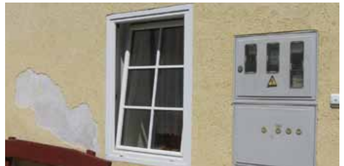
Slika/Abbildung 41: Plastično okno, ki na prvi pogled posnema tradicionalno delitev na šest polj, vendar je pri tem razvrednoten tako njegov estetski kot funkcionalni pomen – jasno je razvidno, da gre za enokrilno, tipsko izdelano okno / Plastikfenster, das auf den ersten Blick die traditionelle Teilung auf sechs Felder nachahmt, jedoch ist hierbei sowohl seine ästhetische als auch funktionelle Bedeutung entwertet – es ist klar ersichtlich, dass es sich hierbei um ein einflügeliges, typisch hergestelltes Fenster handelt
