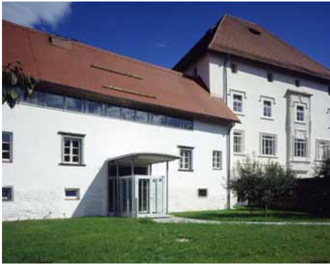
Slika/Abbildung 104: Vrtec - nežen okenski niz in markanten vhod krasita trakt s prostori vrtca. / Kindergarten. Zarte Fensterbänder und eine markante Eingangstüre prägen die alte Fassade des jetzigen Kindergartentraktes.
