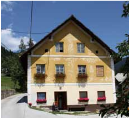
Slika/Abbildung 38: Simetrično razporejeno stavbno pohištvo skladnih velikosti / Symmetrisch angeordnete Fenster einheitlicher Größe (Rateče)
