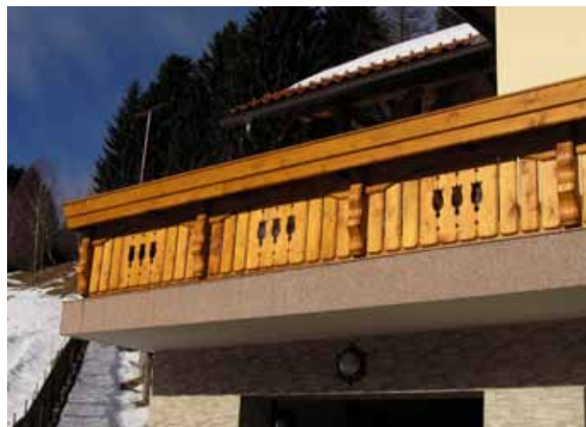
Slika/Abbildung 37: T. i. tirolska ograja z reliefno oblikovanimi latami, ki ne segajo prek pohodne površine ganka oziroma balkona / „Tiroler“ Geländer mit reliefartig gestalteten Latten, die nicht über die Lauffläche des sogenannten „Gank“ bzw. Balkons reichen
