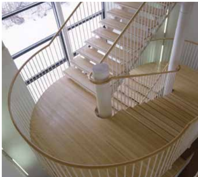
Slika/Abbildung 106: Stopnišče je kot skulptura postavljeno v severni trakt in osvetljeno z visokimi več nadstropij. / Stiegenaufgang - Bildnerische Erziehung. Wie eine Skulptur steht die Stahlstiege im Nordtrakt und wird von hohen Fenstern über mehrere Geschosse belichtet.
