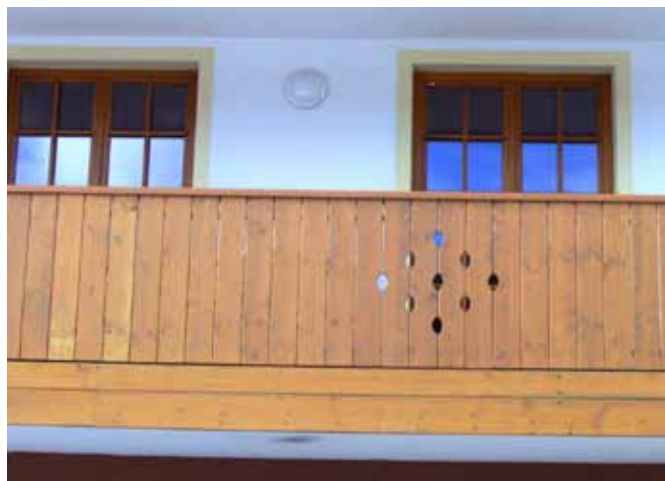
Slika/Abbildung 36: Sodobna izvedba ganka po tradicionalnih vzorih / Moderne Ausführung des sogenannten „Gank“ nach traditionellem Vorbild (Rateče)
