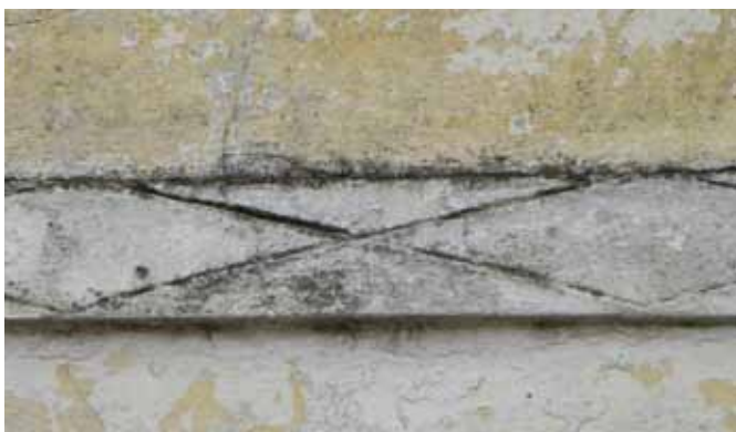
Slika/Abbildung 74: Okrasje, izvedeno v ometu – profilirani zidci, obrobe oken in vrat, v ometu izvedeni šivani vogali / Zierde, ausgeführt im Putz – profiliertes Gesimse, Fenster- und Türumrandungen, im Putz ausgeführte genähte Ecken (Dvorska vas)
