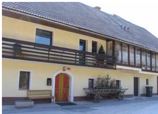
Slika/Abbildung 35: Gank, ki je delno zastekljen in delno zaprt z vodoravno postavljenimi latami / Teils verglaster „Gank“, teils geschlossene, nicht vertikal aufgestellte Latten
