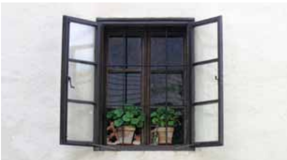
Slika/Abbildung 40: Škatlasto dvokrilno okno, deljeno na šest polj / Kastenförmiges zweiflügeliges Fenster, auf sechs Felder aufgeteilt (Dovje)
