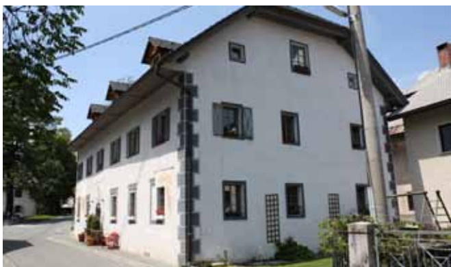
Slika/Abbildung 72: Stenske poslikave: šivani vogali, obrobe oken in ostanki še starejših poslikav / Wandbemalung: genähte Ecken, Umrandungen der Fenster und Reste noch älterer Bemalungen (Podkoren)
