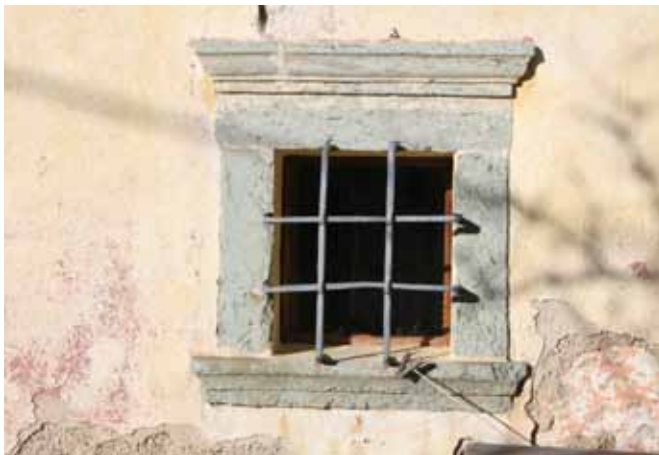
Slika/Abbildung 97: Kamniti okenski okviri iz zelenega peščenjaka, tufa, so značilni za območje Karavank in dajejo arhitekturi značilen pečat. / Steinfensterrahmen, aus grünem Sandstein, Tufa, sind charakteristisch für das Gebiet der Karawanken und verleihen der Architektur ein Gütesiegel.
