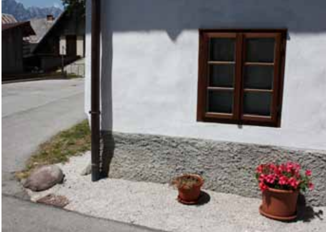
Slika/Abbildung 23: Talni zidec je ometan z grobim ometom in temneje pobarvan kot fasada. / Der Sockel wurde mit grobem Zement verputzt und ist dunkler gefärbt als die Fassade (Rateče)
