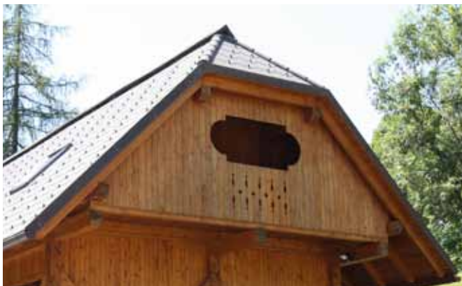
Slika/Abbildung 32: Zatrejni gank na novo zgrajenem objektu / Giebelgank auf neu erbautem Objekt (Rateče)
