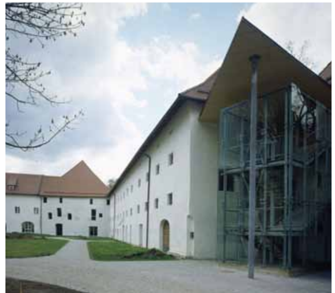
Slika/Abbildung 105: Ustvarjalni prostor v starem zidovju - zastekljen stolp s stopniščem vodi do risalnic v severnem traktu. / Stiegenaufgang Tagesheim – Marienhof. Ein kreativer Ort in alten Gemäuern – der verglaste Stiegenturm führt zu den Zeichenräumen im Nordtrakt.
