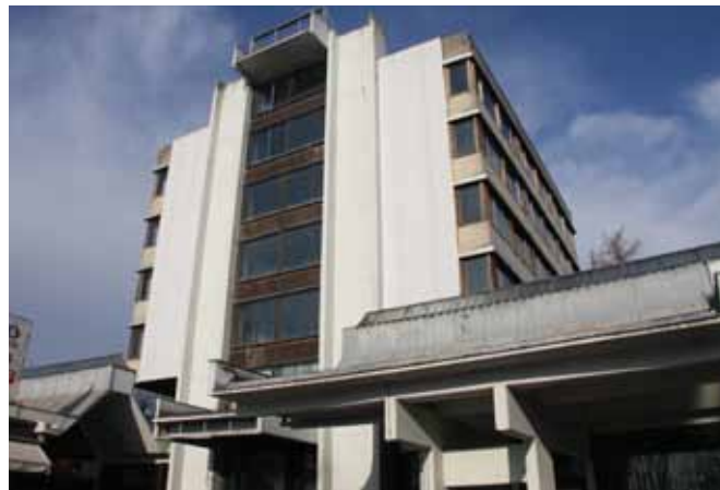
Slika/Abbildung 114: Stavba nekdanjega hotela Transturist je z izgubo funkcionalnih in tehničnih kvalitet značilen objekt, pri katerem ekonomska analiza kaže, da prenova ni več smiselna. / Das Gebäude des einstigen Hotels Transturist ist mit dem Verlust der funktionellen und technischen Qualitäten ein charakteristisches Objekt, bei dem die wirtschaftliche Analyse zeigt, dass eine Renovierung nicht mehr sinnvoll ist.
