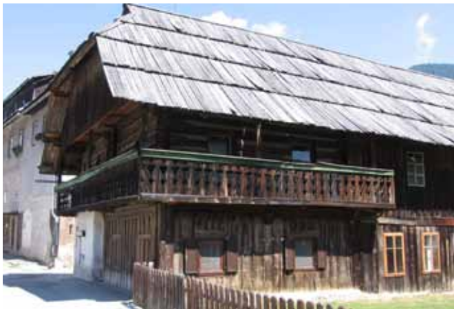
Slika/Abbildung 17: Hiša z delno iz kamna zidanim, delno lesenim pritličjem in nadstropjem, zgrajenim iz brun / Haus teils aus Stein gebautem, teils aus Holz gebautem Erdgeschoss und Obergeschoss, Blockbauweise (Kranjska Gora)
