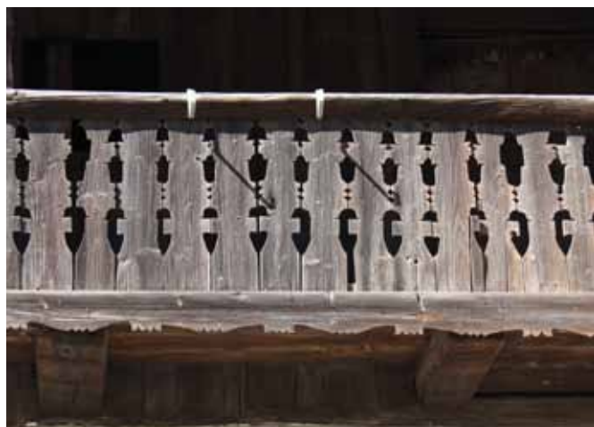
Slika/Abbildung 34: Late so izrezljane, postavljene tesno druga ob drugo, spodaj segajo čez rob pohodne površine / Die Latten sind geschnitzt, dicht aneinander angeordnet, auf der Unterseite reichen sie über den Rand der Lauffläche (Čajna - Nötsch)
