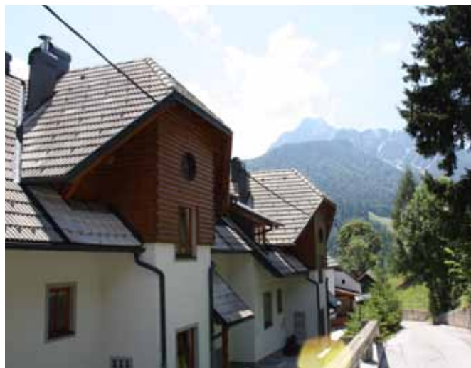
Slika/Abbildung 49: Sodobna, za območje Karavank neznčilna oblika frčad / Moderne, für den Karawankenraum untypische Gaubenform
