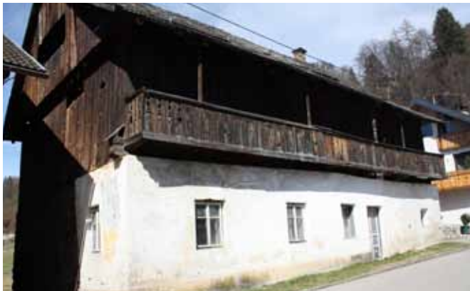
Slika/Abbildung 30: Gank, ki poteka vzporedno z daljšo stranico hiše in je pomaknjen pod napušč / Sogenannter „Gank“, der parallel zur längeren Hausseite verläuft und unter das Dachgesims gerückt ist (Čajna - Nötsch)
