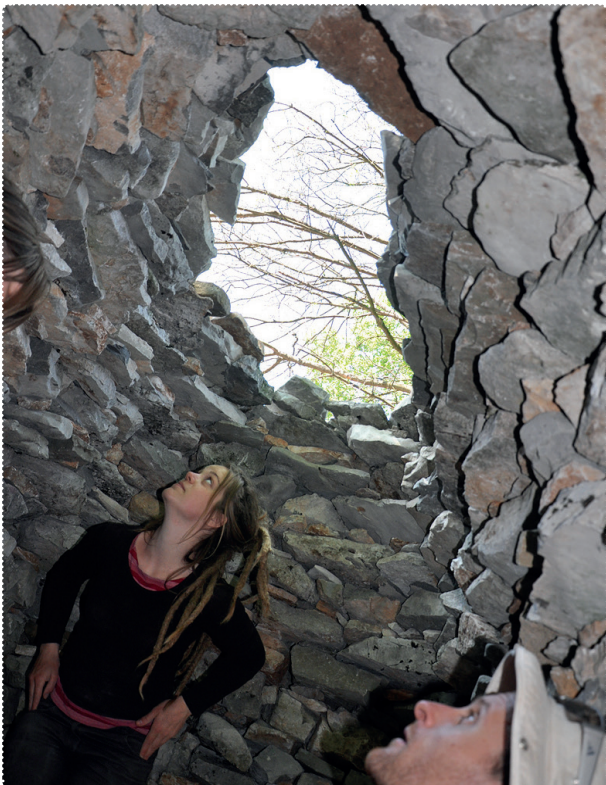
[44] Visoki obok pred zapiranjem. F.: B. Čok
