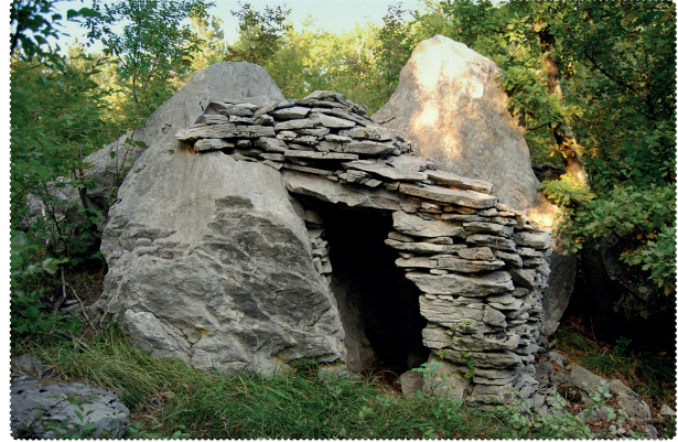
[41] Streha z nagnjenimi skrlami in delnim obokom. F.: B. Čok
