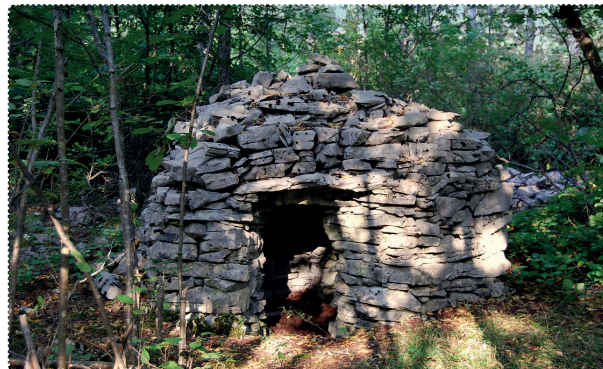
[30] Samostojna Jurčkova hiška na Mravah pri Lokvi je nekaj posebnega. Na zunanji strani je peterokotne oblike, znotraj pa kvadrataste z lepo velbano streho. Vhod je koničen in ima poleg gurenca še kap. Zgradil jo je pastir Jože Čok, po domače Pepi Jurčkov iz Lokve, in je ena od njegovih dvanajstih hišk, ki mu jih pripisujejo. F.: B. Čok
