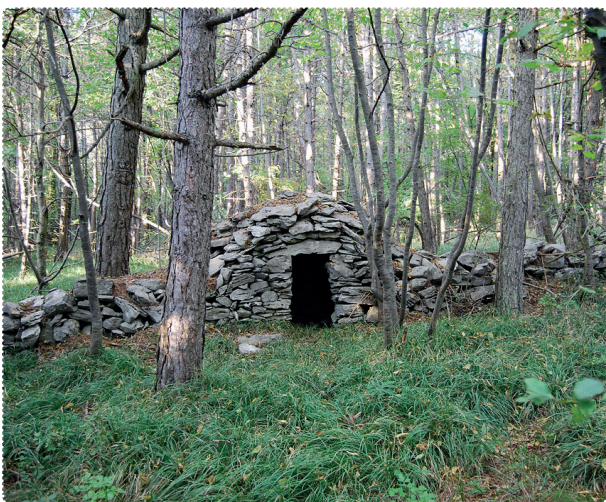
[33] Remonova hiška na Liscu pri Lokvi je vezana v nizkem zidu. Hiška je zidana na klasičen način z lepo vezanimi kamni ob stranicah vhoda, gurencem in visoko obokano streho v kupolo. F.: B. Čok
