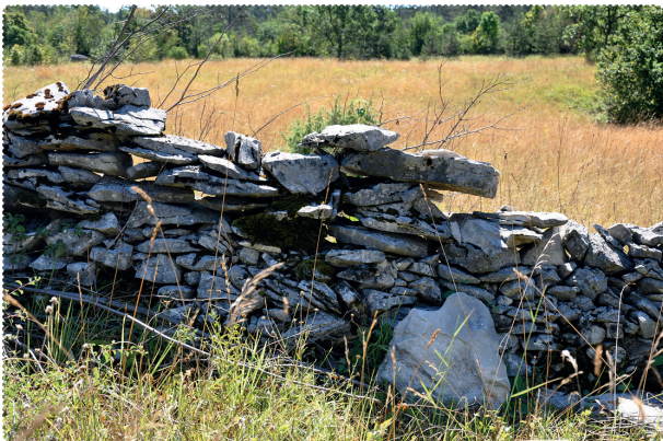
[7] Enojni zid z vodoravno zloženimi kamni ograde Na ravneh pri Lokvi. F.: B. Čok
