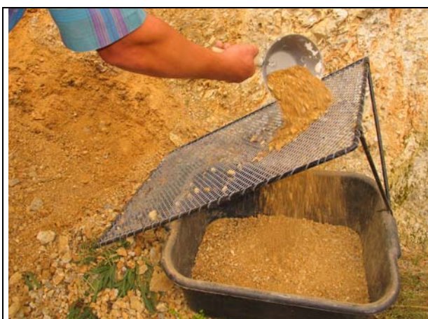
Ročno sejanje peska za manjša popravila fasad.
