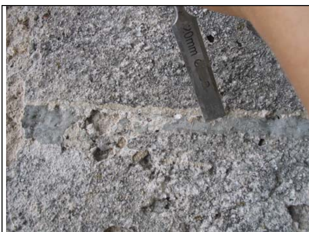
Odstranjevanje cementnih plomb
