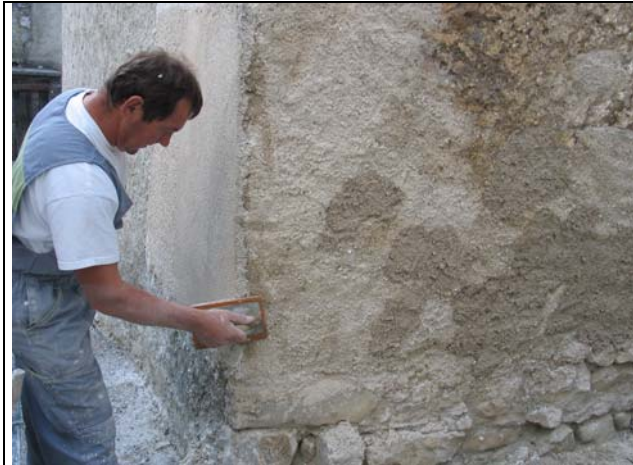
Dvo ali večslojno ometavanje v vdolbinah, poravnavanje vogala - stika med finim ometom in obrizgom
