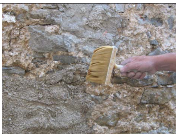
Vlaženje zidu pred ometavanjem
