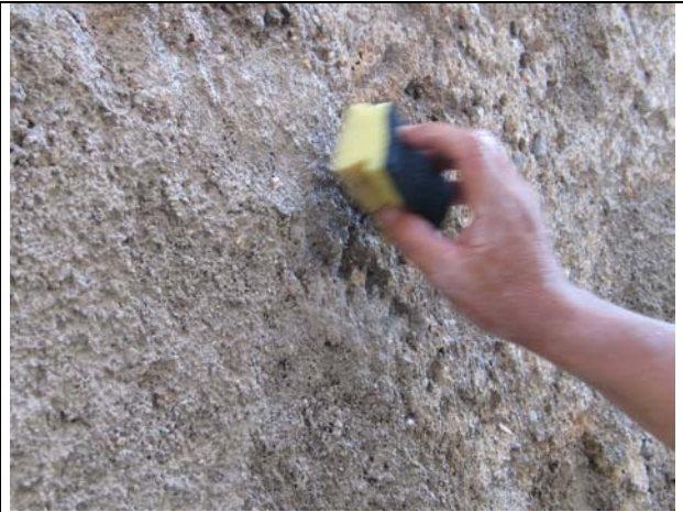
Povdaranje vidnih kamnov- čiščenje odvečne malte
