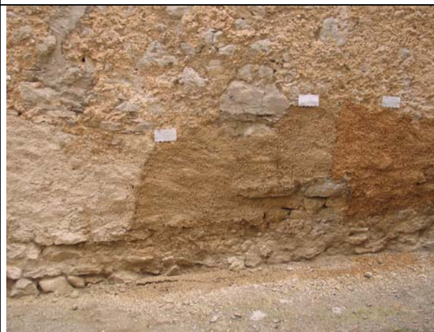
Trije različni odtenki ometa
