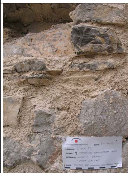
Vzorec popravila kamnitega zidu
