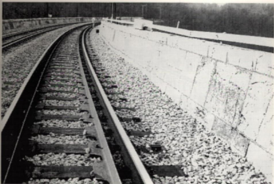
Fig. 5. Parapet droit du pont de la vallée: sur sa face intérieure, c.-à.-d. tournée vers la voie se trouvent les marques de tailleur de pierre; décembre 1997.
