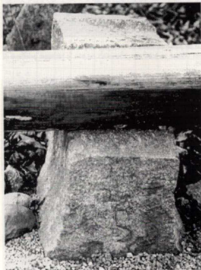
Fig. 4. Marque de chiffre de tailleur de pierre, un 5, sur la face inférieure de la console de l'ancien viaduc de Borovnica. Aujourd'hui la console sert de pied à un banc de jardin à Ljubljana. Janvier 1998.
