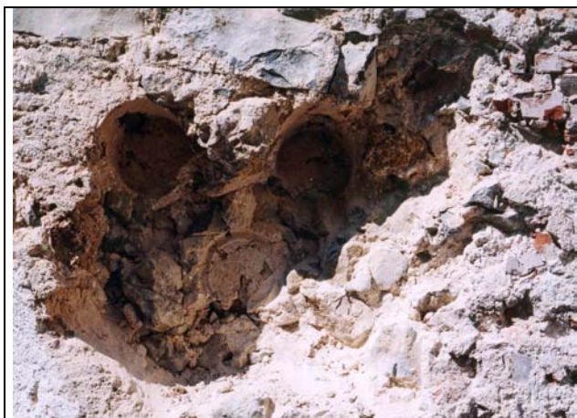
9 Detajl odtisa bifornih stebričev v zidu po njihovem odkritju in izdvojitvi iz zida
