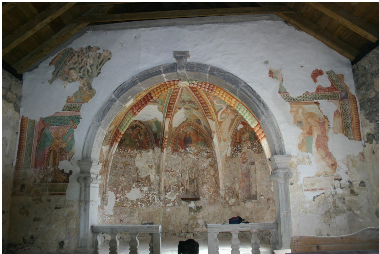
Pogled na prezbiterij in slavoločno steno po končanem posegu.
