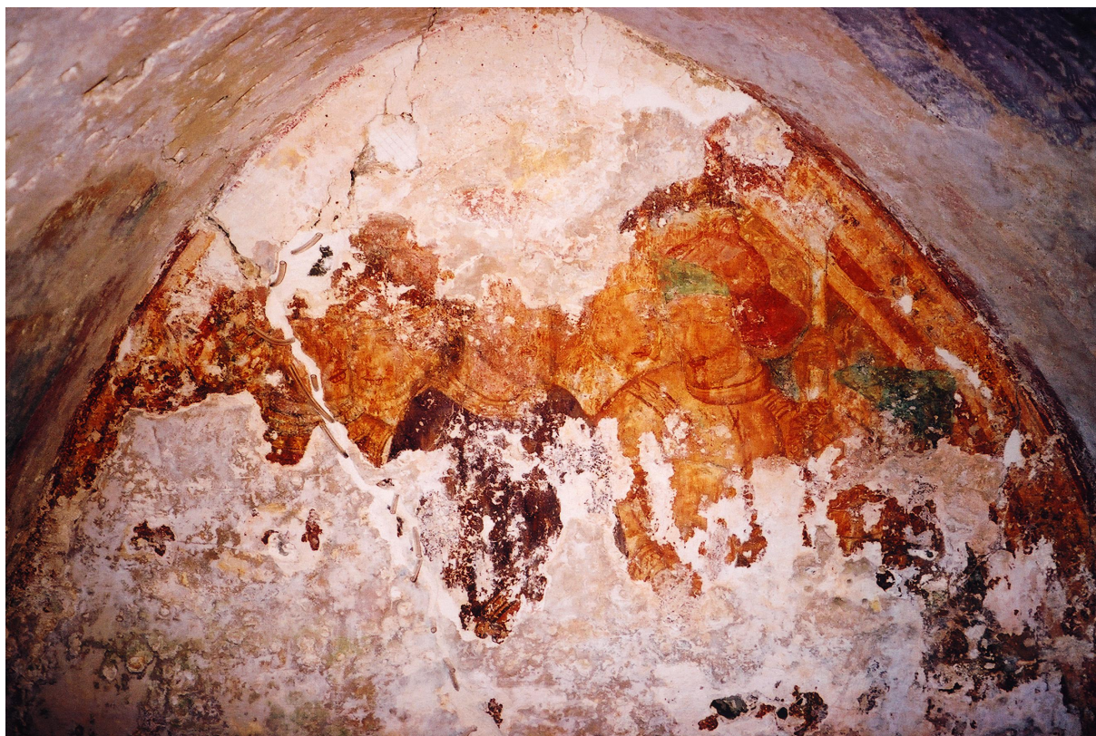
Vzhodna stena zgoraj med odstranjevanjem zasiganih ometov in beležev ter soli – vendar nekaj dni pozneje. Z injektiranjem smo še nadaljevali.
