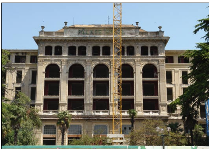
Začetek sanacije hotela Palace (posnetek 26. 6. 2006)
