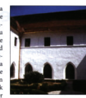
Obnovljene fasade križnega hodnika
