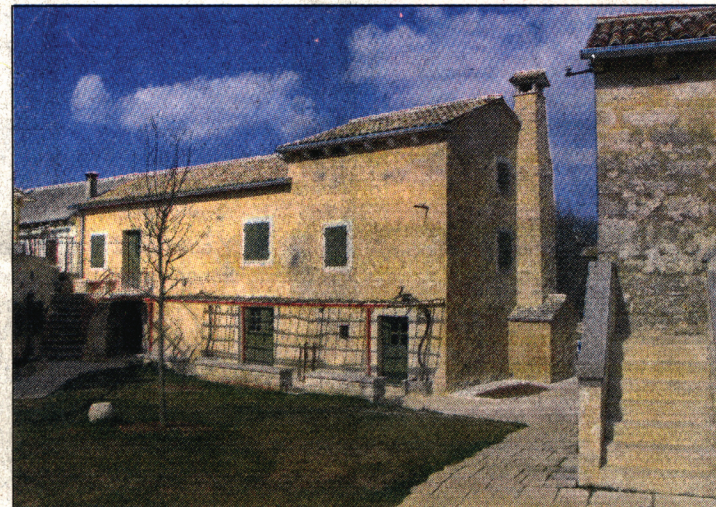
Primer restavriranja fasade z apnim postopkom in z barvili lokalnega izvora, hrvaška Istra.
