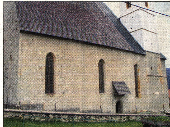
Primer fasade cerkve Sv. Petra v Dvoru pri Polhovem Gradcu. Cerkev ima vklesano letnico začetka gradnje 1525, fasada se je ohranila do zdaj, torej je stara več kot 450 let. Jo bomo (kot običajno) preplastili z belim apnenocementnim ometom?
