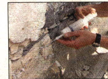
Primer konservacije izvornika – injektiranje odstopljene plasti.
