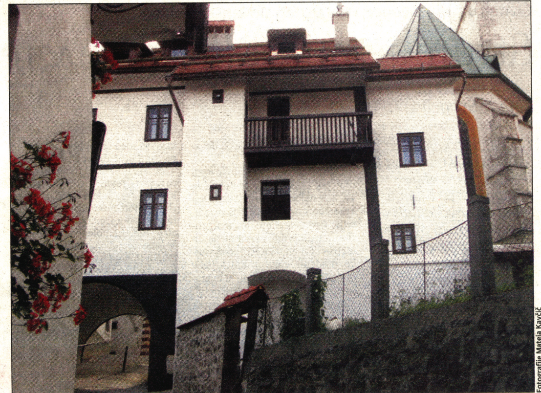
Primer restavriranja fasade z apnim postopkom, Škofja Loka.
