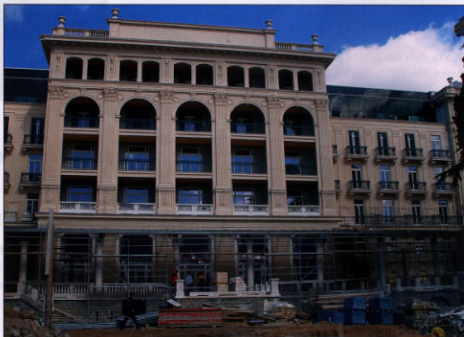
Obnova portoroškega hotela Palace je že skoraj končana.
