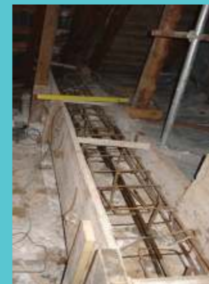
Izvedba AB okvirja • Vir: Arhiv GI ZRMK
