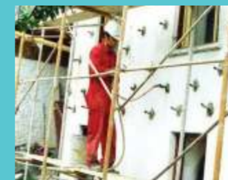
Sistematično injektiranje kamnite stavbe • Vir: arhiv GI ZRMK
