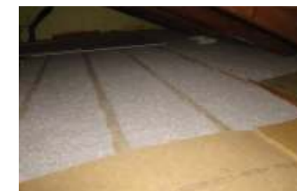
Primer izolacije ravnega stropa proti podstrehi s celuloznimi kosmiči. Avtor fotografije: Igor Premzl
