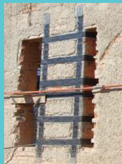
Ojačitev stopa med odprtinama s karbonskimi trakovi. Avtor fotografije: Mojca Jarc Simonič
