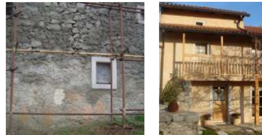
Prikaz priprave vzorcev za določitev najprimernejše sestave nove, tonirane apnene malte (levo) ter izvedena nova apnena fasada. Avtor fotografij: Nataša Kolenc
