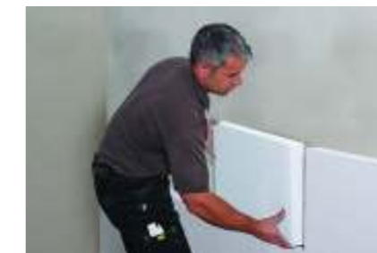
Izvedba notranje izolacije s ploščami kalcijevega silikata.
