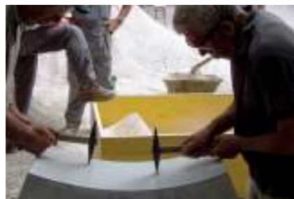
Kamnoseška izvedba manjkajočih delov kamnitega portala (izvedba replike nekdanjega portala). Avtor fotografij: Nataša Kolenc
