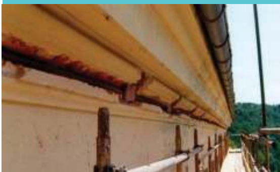
Vgradnja jeklene vezi pod napuščem. Vir: Arhiv GI ZRMK
