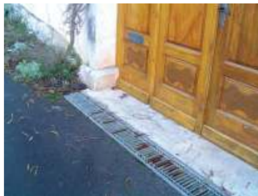
Odočna rešetka preprečuje zlivanje vode z ulice v notranjost objekta. Avtor fotografije: Nataša Kolenc
