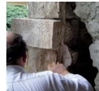
Obstoječe kamnoseške izdelke ohranjamo. Pri njihovem čiščenju se je smiselno izogibati abrazivnim sredstvom, ki s »praskanjem« lahko poškodujejo površino kamna. Neprimerno je na novo naštokati ali kakor koli drugače agresivno poseči v kamnite elemente z namenom, da bodo izgledali kot novi. Pravi čar prostoru dajo prav elementi, ki imajo ohranjeno staro patino. Avtor fotografije: Nataša Kolenc
