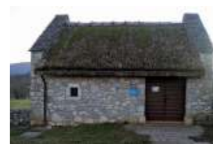
Rekonstrukcija slamnate kritine. Avtor fotografije: Stanko Vitez
