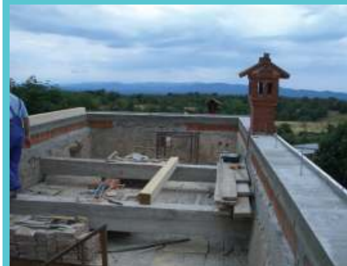
Izvedba AB venca ob kapu • Avtor fotografije: Dario Grilanc
