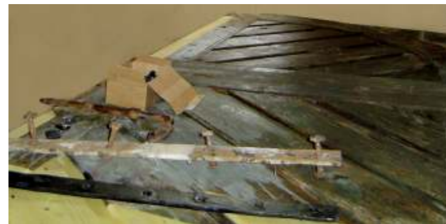
Enaka pozornost kot lesenim delom, je bila posvečena tudi obnovi okovja in drugih kovinskih elementov, ki so pogosto oblikovno zelo zanimivi, še vedno uporabni, a kljub temu zavrženi. Dela pri obnovi kovinskih delov je opravil mojster kovač. Avtor fotografije: Nataša Kolenc
