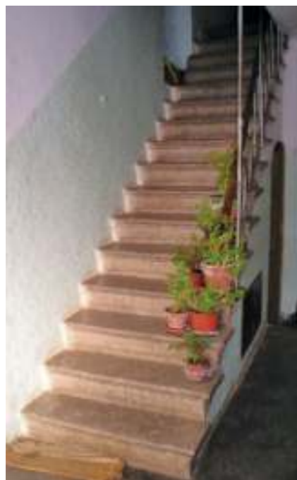
Gabrje - kamnito notranje stopnišče. Vir: Arhiv OCRA Obrtni center restavradorstva d.o.o.
