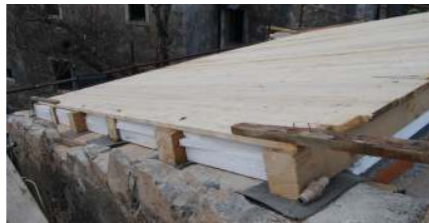
Primer toplotne izolacije med špirovci • Avtor fotografije: Stanko Henigman
