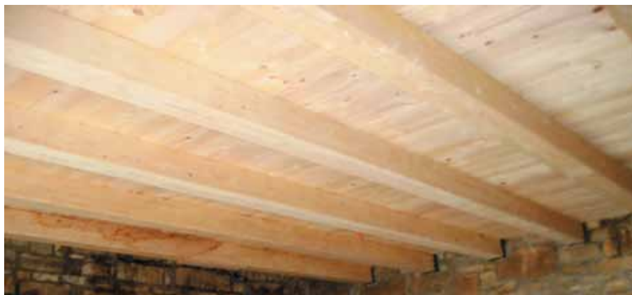
Foto 106: Nova stropna konstrukcija v kleti Grondalove domačije v Abitantih
