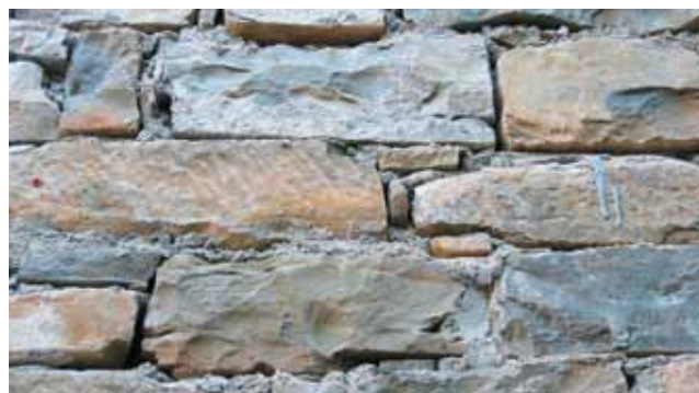
Foto 52: Šmarje, primer solidne obnove kamnitega zida
