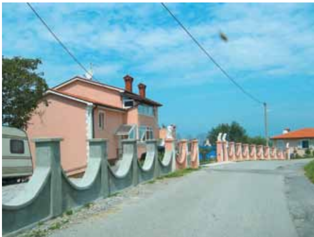
Foto 8: Novogradnja pred Borštom
