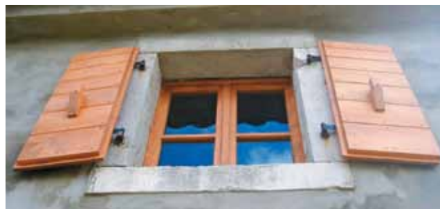
Foto 79: Obnovljena okno in polkna na solinski hiši v Muzeju solinarstva
