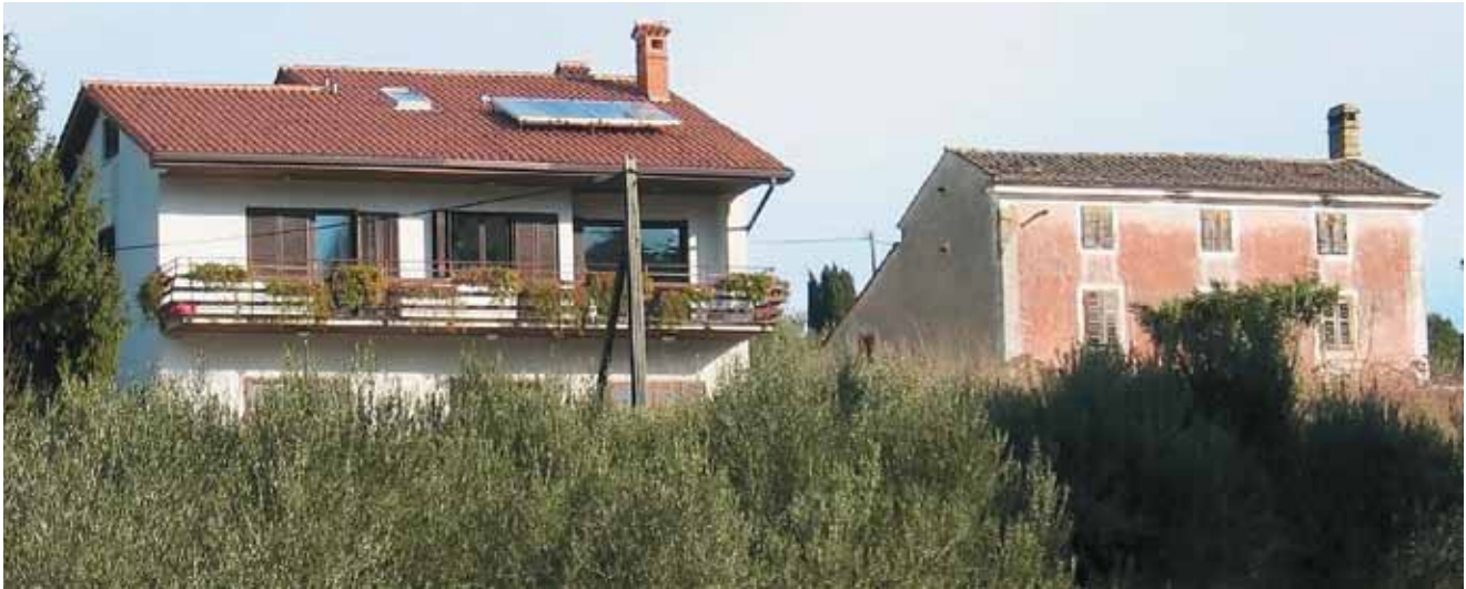
Foto 21: Stara in nova hiša v Strunjanu: primerjava kaže, kako se nova gradnja ne ozira na lokalne značilnosti: glavna fasada, »obraz« hiše, ki pri stari hiši ponosno gleda proti cesti, je pri novi hiši izmaličen s prevelikim napuščem, balkonom in predimenzioniranimi fasadnimi odprtinami.
