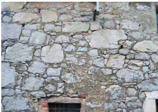
Foto 26: Zid iz apnenca v Dolu pri Hrastovljah
