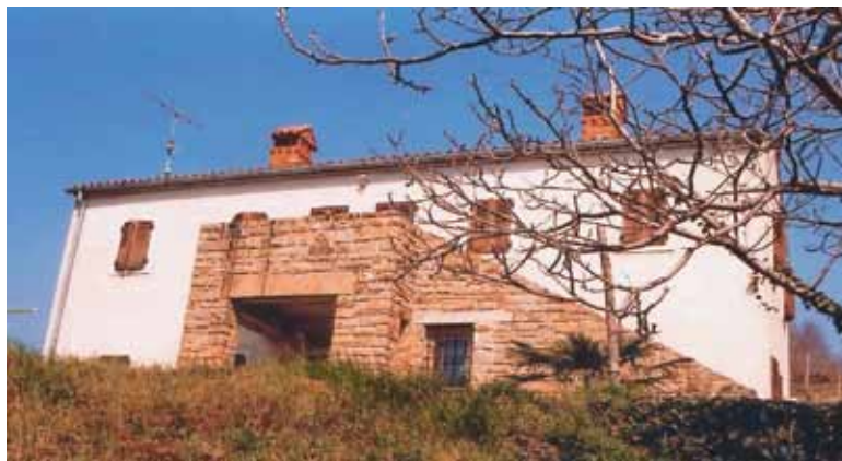
Foto 59: Dober primer novogradnje v Srگاših s kamnitim baladurjem
