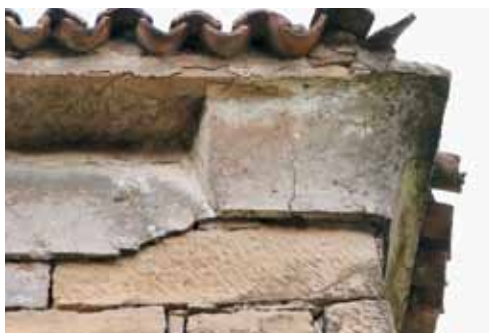
Foto 72: Ometan strešni venec v Laborju
