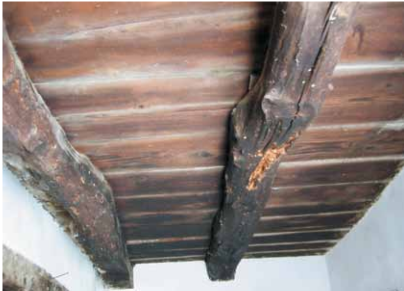
Foto 105: Ohranjena stropna konstrukcija v Smokvici
