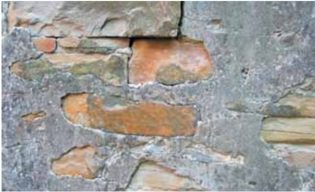
Foto 47 in 48: Ostanki fasadnega ometa na hiši v Šmarjah in Smokvici
