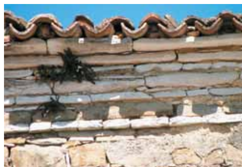
Foto 73: Podlaga za ometan strešni venec v Reparcu
