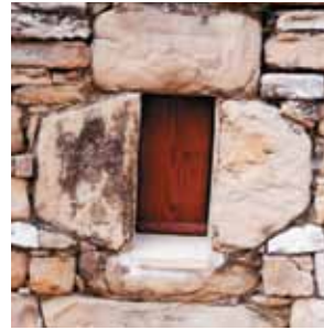
Foto 34: Lina na fasadi
