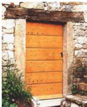
Foto 78: Obnovljena vrata v Smokvici
