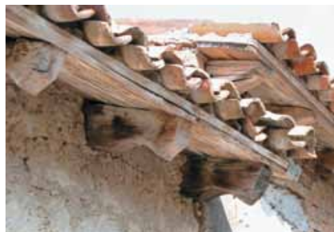
Foto 71: Lesen strešni venec v Zazidu
