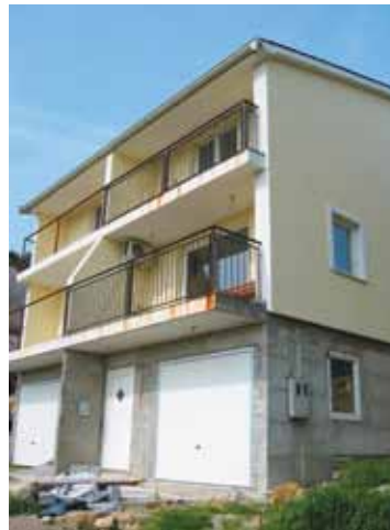
Foto 9: Gradnji za trg v Grbcih
