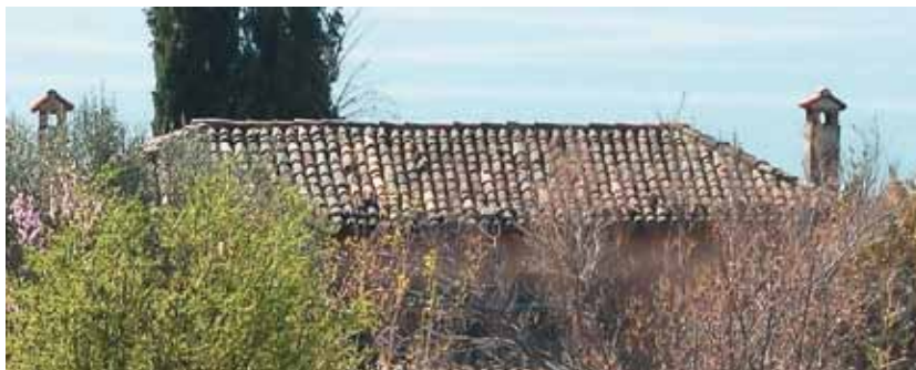
Foto 66: Štirikapna streha z ustreznim naklonom
