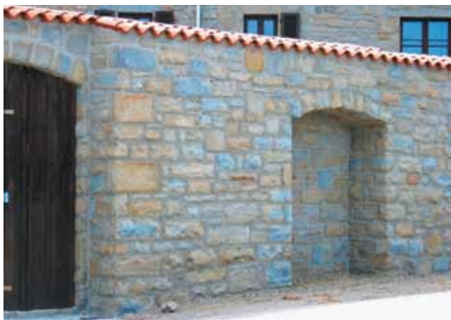
Foto 49: Gradnja dvoriščnega zidu z debelimi cementnimi fugami
