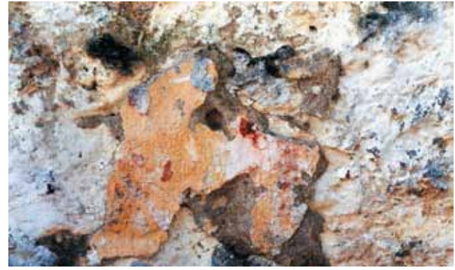
Foto 47 in 48: Ostanki fasadnega ometa na hiši v Šmarjah in Smokvici
