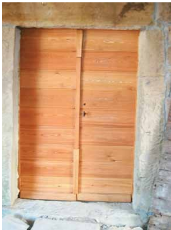
Foto 130: Obnovljena kletna vrata
