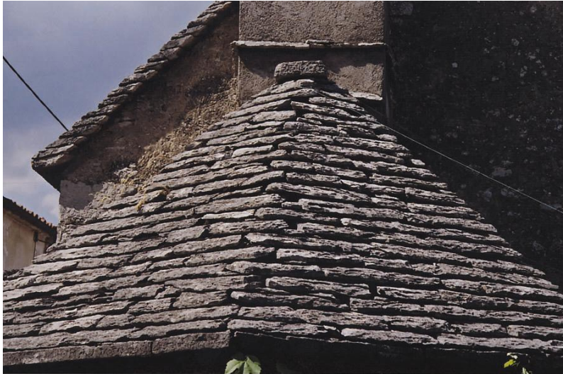
Slika 30 Zgleden greben iz samih polovičnih grebenjakov na spahnjenici pri Blaževih v Gorenjah pri Divači.
