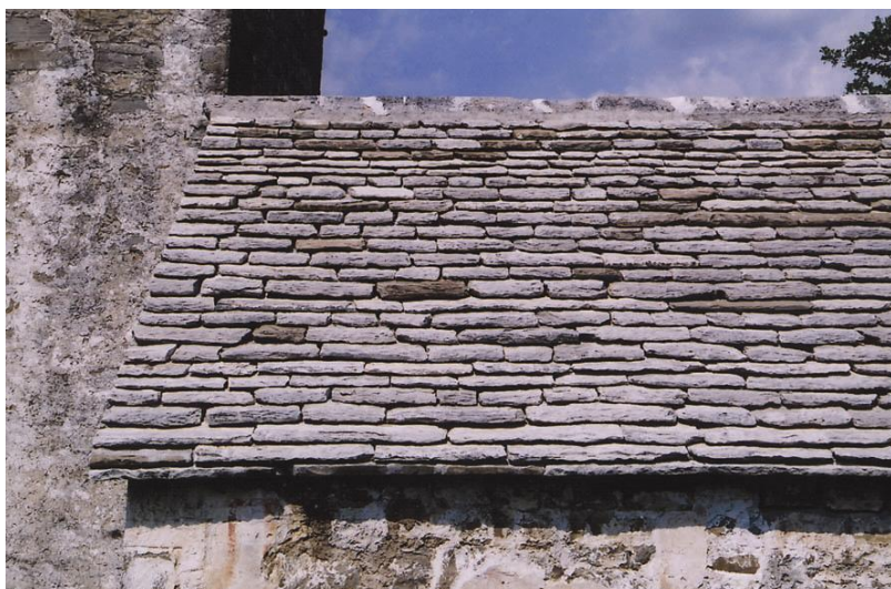
Slika 65 Detajl dvakrat rekonstruirane strehe cerkve sv. Štefana v Zanigradu.
