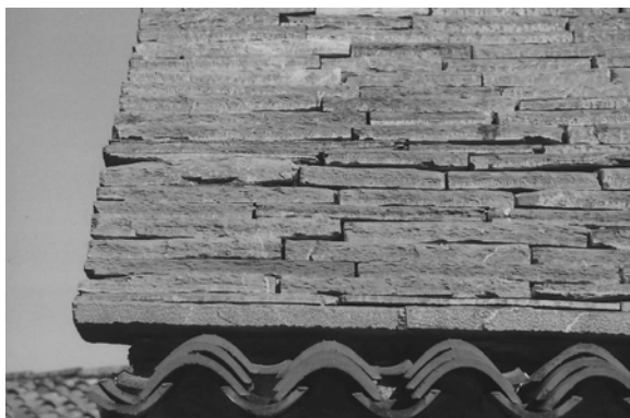
Slika 74 in slika 75 Strehe na domačiji Vrčevih v Gabrovici so bile deloma prekrite z novimi avtohtonimi črnimi skrilami, kar je danes velik dosežek, vendar niso bile pravilno oblikovane in obdelane. Zatrejni venec, ki bi moral biti poševno rezan, je stopničast, njegova čela so raskana, namesto da bi bila obdelana s kladivom ali odbijačem. Čela strešnih skril niso poševno posneta, čela kapnih skril pa so obdelana preveč fino.
