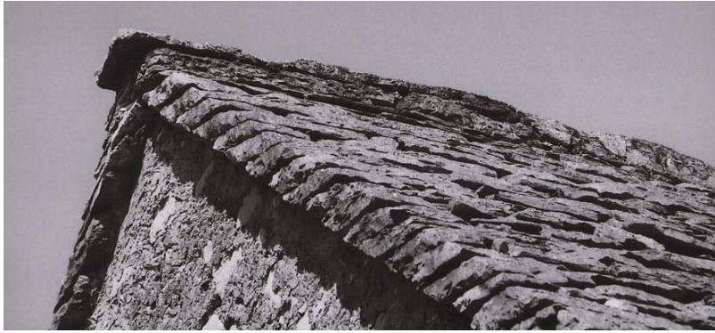
Slika 33 Zidano sleme na hiši pri Turkovih v Godnjah: vrhnji začetni slemenjak ima obvezen večji previs kot spodnje skrile in skrile zatrepnega venca.
