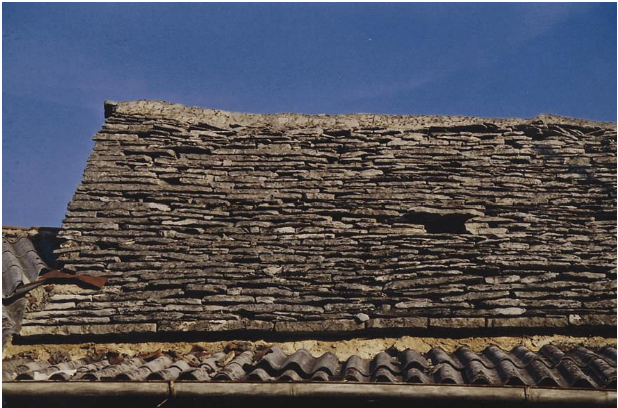
Slika 59 Ometano zidano sleme na skrilnati strehi Jerinovih v Šepuljah.
