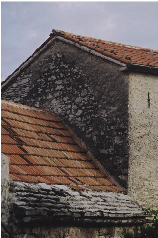
Slika 5 Nekdanja slamnata streha na stari kuhinji in hramu pri Poljkovih v Povirju, na kateri so se ohranile skrile na kapu in zatrepu, slama pa je bila nadomeščena z opečnim zareznikom. Na zatrepni steni stanovanjske hiše na desni je videti obris strmega zatrepa nekdanje skrlnate strehe.
