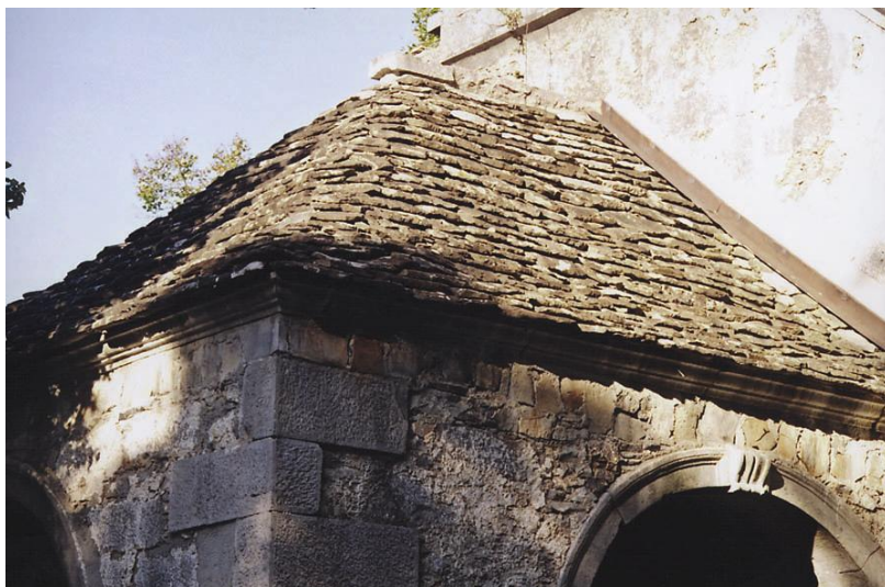
Slika 73 Streho lope pri cerkvi sv. Antona v Šepuljah so pri obnovi prekrili z rjavim flišnim peščenjakom iz Vremske doline, ki za strehe na Krasu ni primeren.
