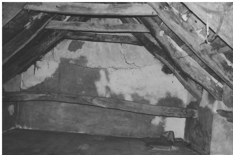
Slika 13 Ostrešje z goltniškimi povezji in s pozidnicami na visokem podstrešju domačije Petróvih v Tupelčah. Videti je enega izmed štirih poveznikov, v desnem zidu pa del pozidnice, na katero nalegajo
