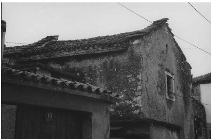
Slika 47 Domačija Ivanovih v Merčah s korci na položni dvokapni strehi in skrili na kapu in na povišanih položnih zatrepnih zidih. V vrhu zatepa ima v omet vrezano letnico 1825.
