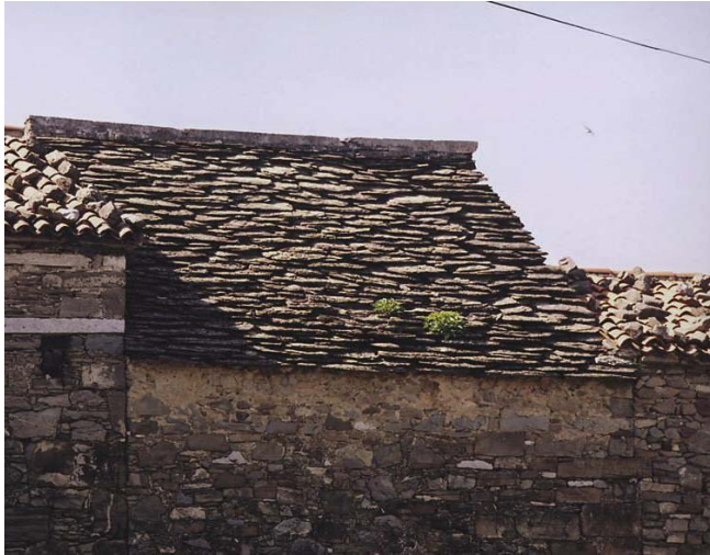
Slika 3 Zunanja stran Šmitovega hleva v Podnanosu. Krit je s skrilami sivega flišnega peščenjaka, ki jim je zob časa dal značilno zaobljeno obliko.
