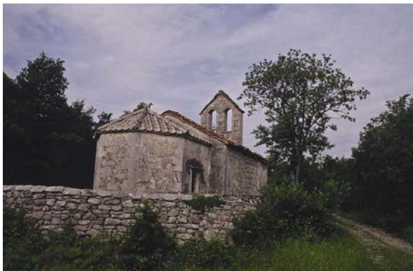
Slika 52 Cerkev sv. Brijcija pri Naklem s salonitno kritino na prezbiteriju. Skrlnato streho na ladji so zamenjali s korèno že prej.
