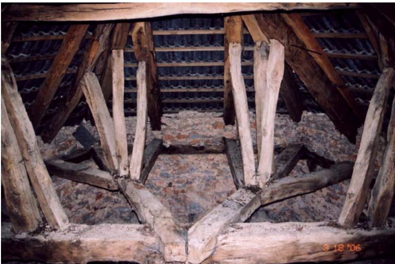
Slika 18 Povezava poveznika in pozidnic nad prezbiterijem cerkve sv. Petra in Pavla v Tomaju.
