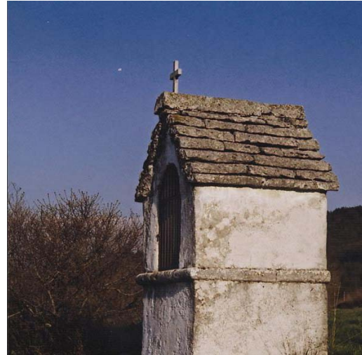
Slika 4 Kapelica sv. Jurija na razpotju poti iz Lokve v Prelože. Datirana je z letnico 1896 na čelu slemenjaka strehe iz masivnih apnenčevih skril
