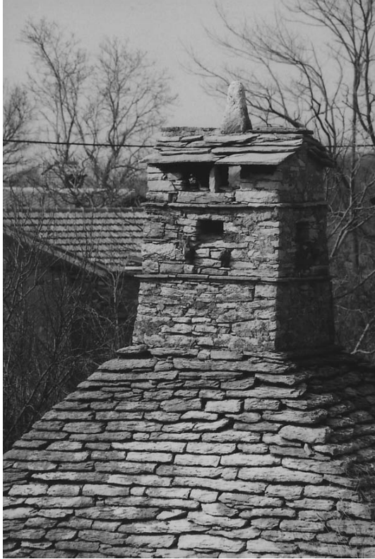
Slika 29 Dimnik na spahnjenici pri Kavalinovich v Povirju ima dva tenka skrilnata odkapnika, na skrilnati strešici pa enega izmed redkih ohranjenih stožčastih nastavkov.
