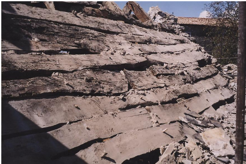
Slika 9 Del ostrešja skrilnate strehe skednja pri Slamčevih v Pliskovici z debelimi hrastovimi krajniki, ki so pribiti z manjšimi lesenimi klini. Ti klini so bili hkrati tudi sidra proti zdrsu kritine. Foto Viliem Perčič.
