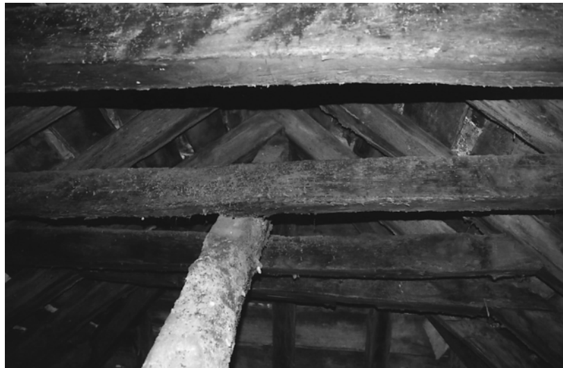
Slika 17 Pri ostrešju trikapne skrilnate strehe nad prezbiterijem cerkve sv. Vida v Podnanosu je stekališče škarnikov in robnikov podprto z dolgim opornikom.
