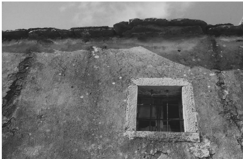
Slika 38 Pri Tonkovih v Krajni vasi rabi za napušč nad oknom naprej pomaknjena večja skrila v strešnem kapu.
