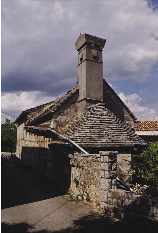
Slika 71 Stara hiša Blaževih v Gorenjah pri Divači je antologijski zgled skrilnatih streh in detajlov.
