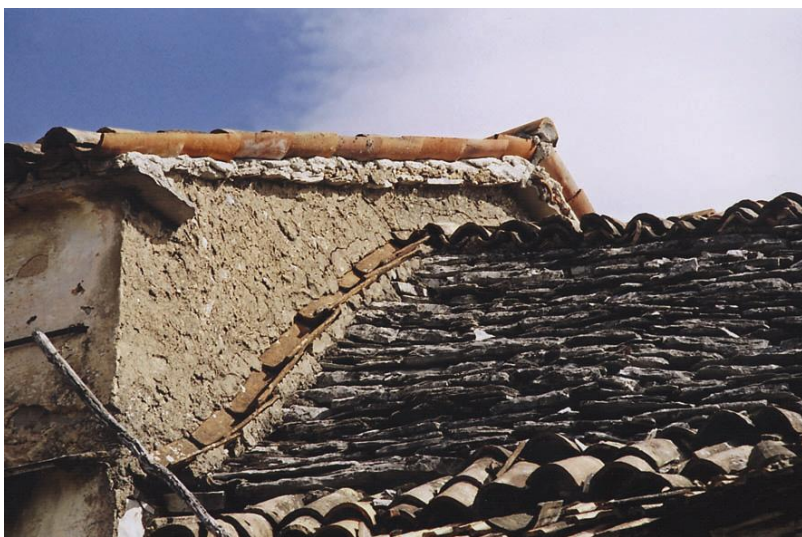
Slika 62 Na Tonkovi hiši v Krajni vasi so stik med skrlnato streho in zidom pokrili z žlebičem iz korcev, položenih v malto.
