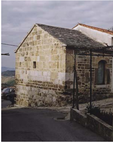
Slika 57 Zatrepana in hrbtna stran Benkove hiše v Črnem Kalu z rekonstruirano skrlnato streho. V latinskem napisu na portalu je datirana z letnico 1489.
