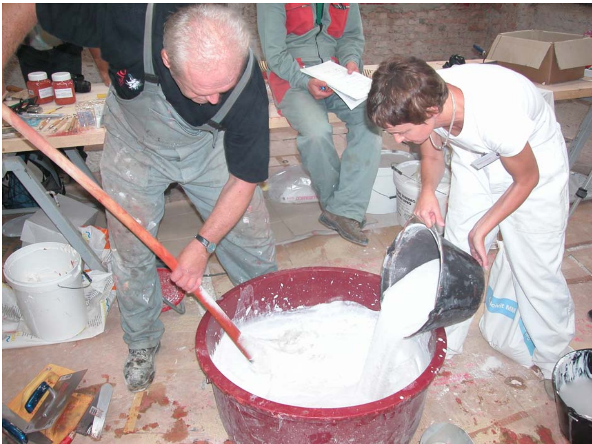
Slike 78, 79 in 80 Priprava malte z gašenim apnom (foto: Mateja Kavcic).
