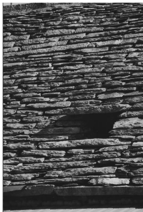
Slika 21 Na strehi hiše Markotovih v Godnjah so čela nekaterih skril (nad lino) izjemoma poševno posneta po vsej višini.
