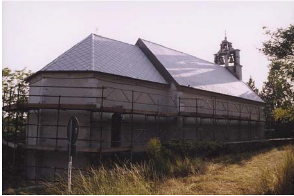
Slika 50 Nekdanja skrlnata streha cerkve sv. Urha v Samotorici na Tržaškem je bila leta 2004 že drugič prekrita s »špičakom«.
