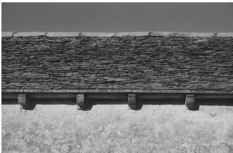
Slika 25 Cerkev Marijinega vnebovzetja na Gori nad Povirjem: precej globoke klesane spodnje kapne skrile na konzolicah. Na slemenu so lepo vidne zveze slemenjakov na preklop.
