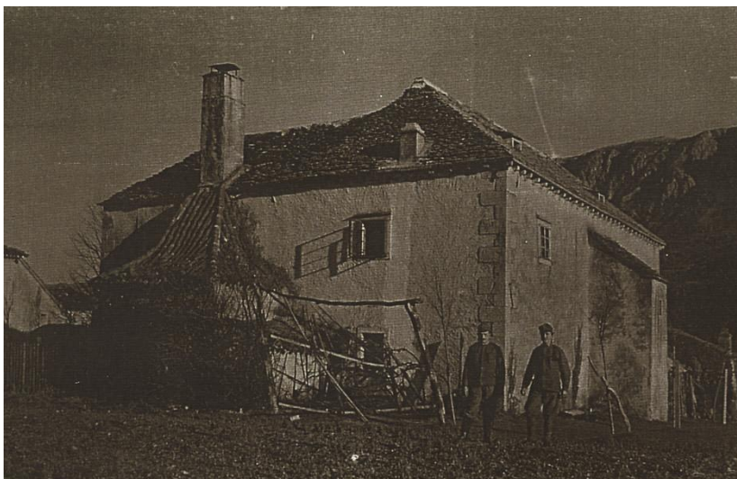
Slika 40 Izjemne frčade, krite s skrilami, na nekdanji skrilnati strehi Zajčjega grada v Podnanosu. Posneto verjetno med prvo svetovno vojno. Hrani Edo Tavčar, Ljubljana / Podnanos.
