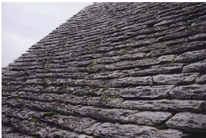
Slika 8 Odlično ohranjena streha iz masivnih skril kompaktnega povirskega apnenca pri Pikcovih v Divači.
