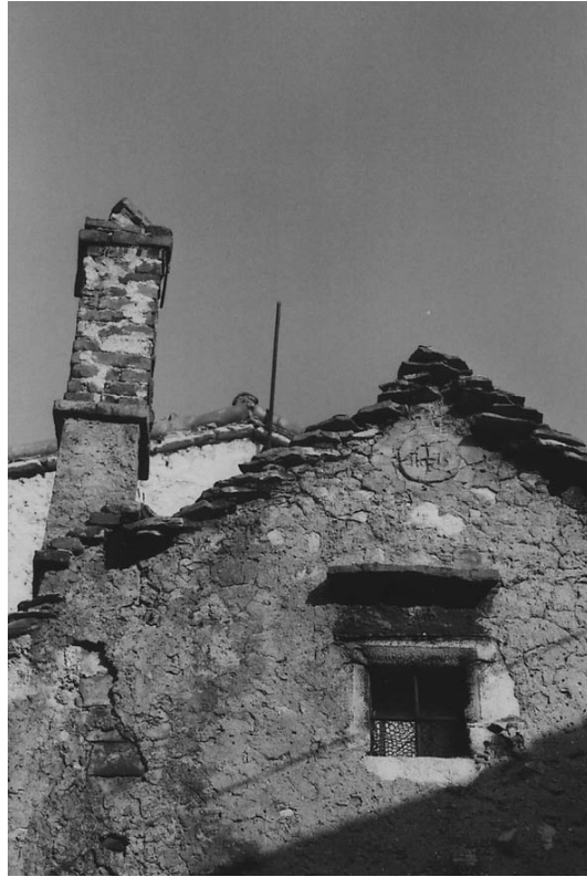
Slika 27 Rustikalen zatrepni venec pri Orlečánovih v Žirjah.
