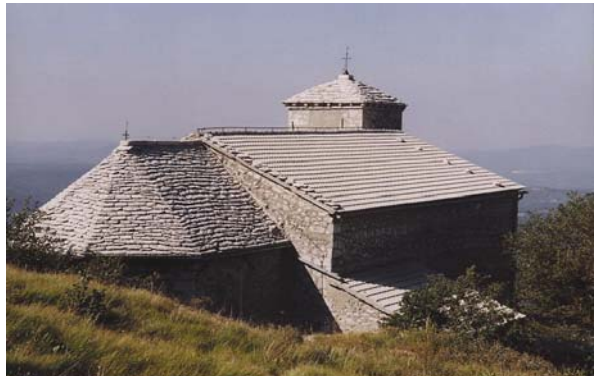
Slika 53 Cerkev sv. Hieronima na Nanosu, ki je bila prvotno vsa krita s skrilami. Že pred prvo svetovno vojno so skrlnato streho na ladji zamenjali s korèno, pri zadnji obnovi pa so jo prekrili s sivimi betonskimi strešniki, ki se lepo ujemajo s sivino skrlnatih streh.
