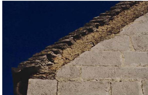
Slika 23 V zatrepnem vencu strehe kapele Marije pomočnice v Lokvi – v katerem je kljub ometu videti globino plasti skril, je videti gostota njihovega prekrivanja.
