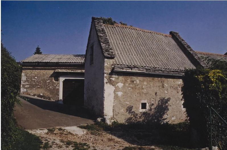
Slika 7 Slamnato streho na gospodarskih poslopijih pri Mohorajevih v Vogljah so prekrili z valovitimi salonitnimi ploščami. Ohranjene so še apnenčeve skrole na zatrepih in kapih.
