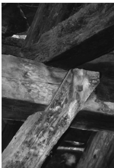
Slika 19 Cerkev sv. Vida v Podnanosu: zveza ročice in gornje lege s sklopom na polovični lastovičji rep.
