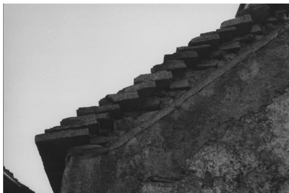
Slika 74 in slika 75 Strehe na domačiji Vrčevih v Gabrovici so bile deloma prekrite z novimi avtohtonimi črnimi skrilami, kar je danes velik dosežek, vendar niso bile pravilno oblikovane in obdelane. Zatrejni venec, ki bi moral biti poševno rezan, je stopničast, njegova čela so raskana, namesto da bi bila obdelana s kladivom ali odbijačem. Čela strešnih skril niso poševno posneta, čela kapnih skril pa so obdelana preveč fino.
