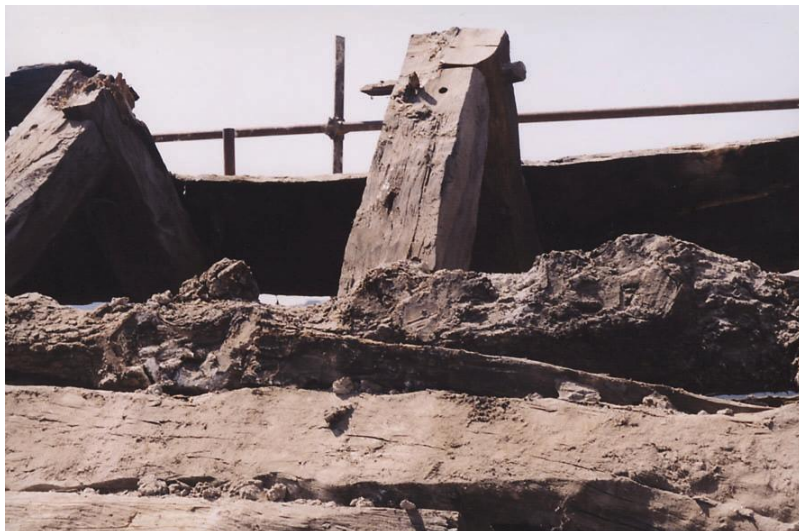
Slika 10 Slamčev skedenj v Pliskovici: škarnika, zvezana z vogalnim preklopom in zbita z lesenim klinom. Foto Viljem Perčič.
