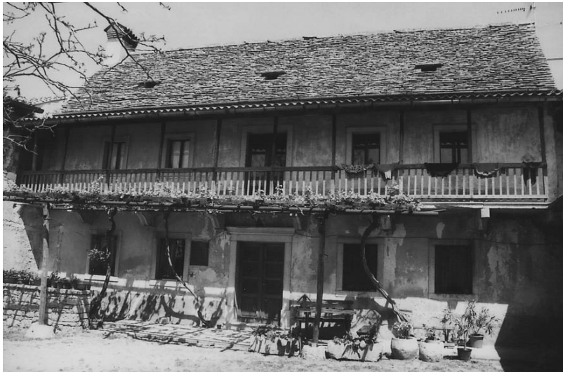
Slika 45 Hiša Urbaníčevih na Filipčjem Brdu z najmlajšo datirano skrlnato streho na Krasu iz leta 1865.
