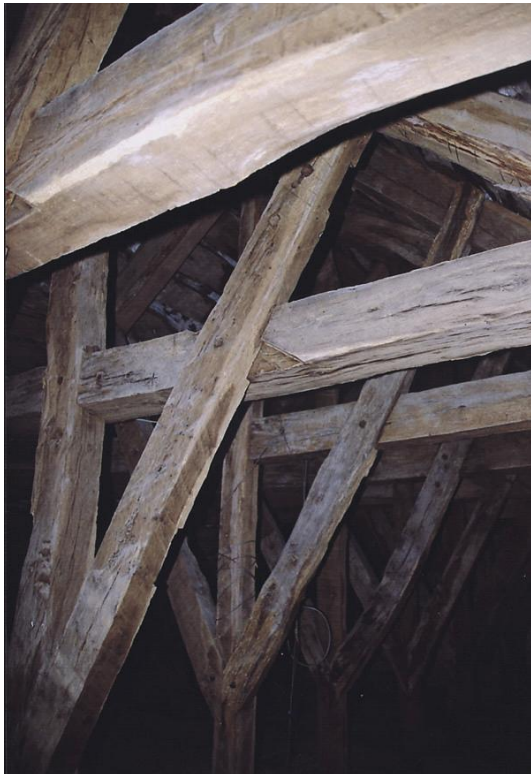
Slika 63 Odvečni useki za tesarske zveze kažejo, da je bilo ostrešje cerkve v Šmarjah pri Sežani predelano. Na to kaže tudi delna uporaba kovanih žeblicev.
