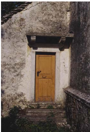
Slika 37 Napušč iz masivne klesane plošče na konzolah nad vhodom v zakristijo cerkve v Šmarjah pri Sežani.
