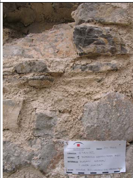
Vzorec popravila kamnitega zidu
