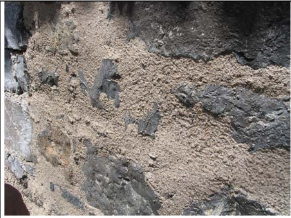
Enakomeren vzorec vidnih kamnov v zidu
