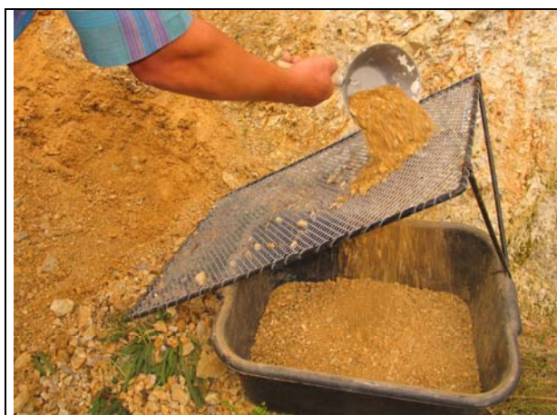
Ročno sejanje peska za manjša popravila fasad.
