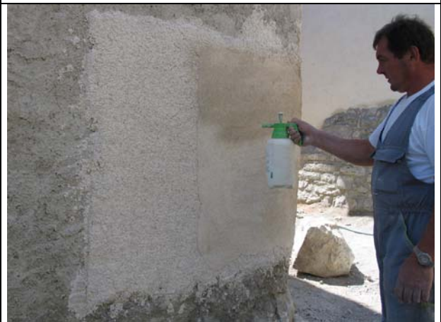
Omet negujemo – vlažimo med sušenjem.
