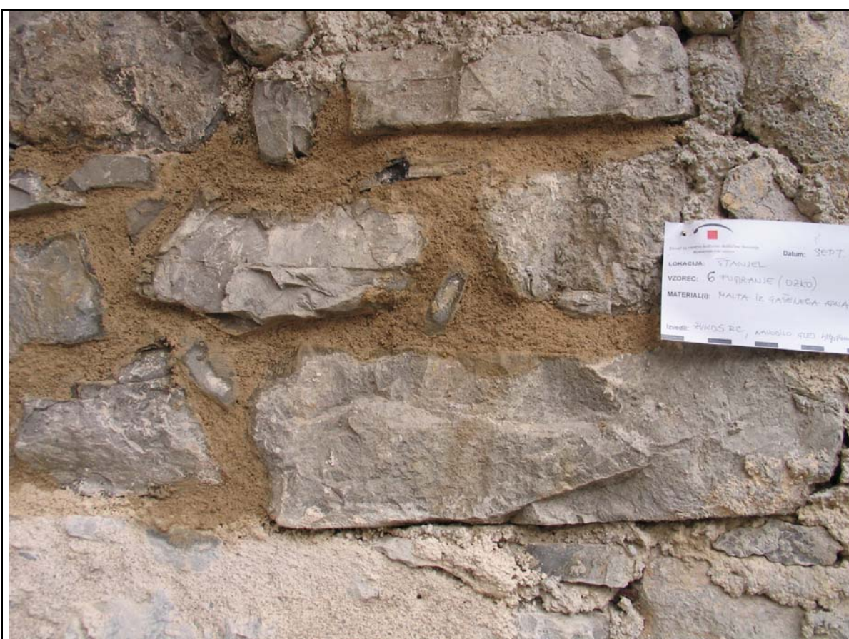
Vzorec izvedbe »ozkega« fugiranja na hiši Markočič, Štanjel, 2006
