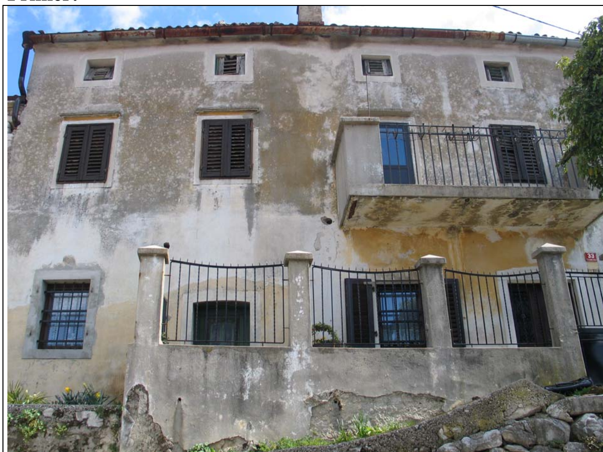
Primer ometa na fasadah hiš Pilat in Furlan v Štanjelu, 2006
