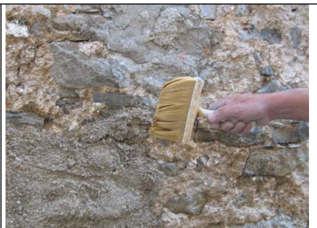
Vlaženje zidu pred ometavanjem
