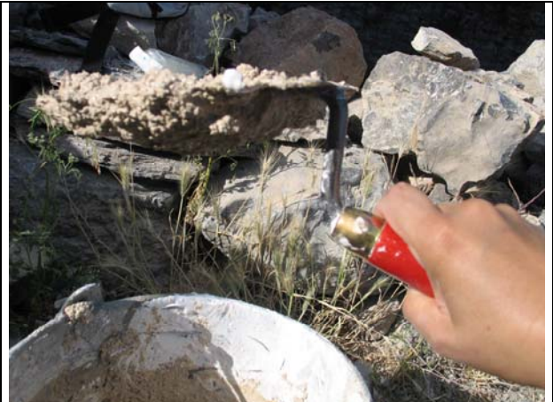
Pravilno pripravljena malta ostane na obrnjeni zidarski žlici.
