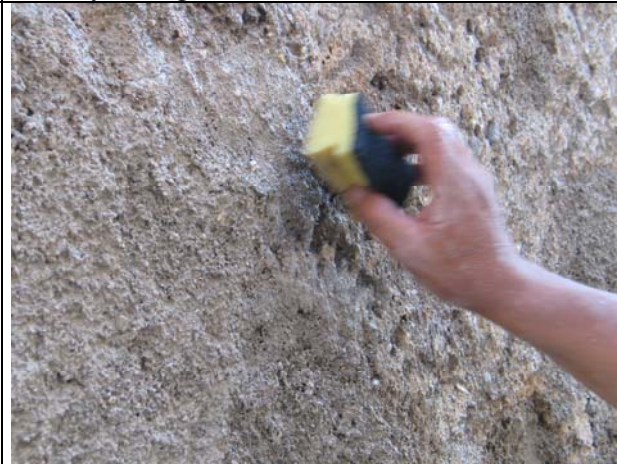
Povdarjanje vidnih kamnov- čiščenje odvečne malte
