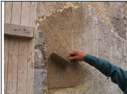
Zapolnjevanje praznin s finalnim ometom
