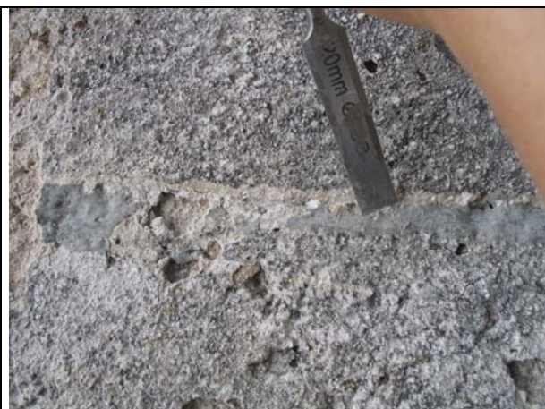
Odstranjevanje cementnih plomb
