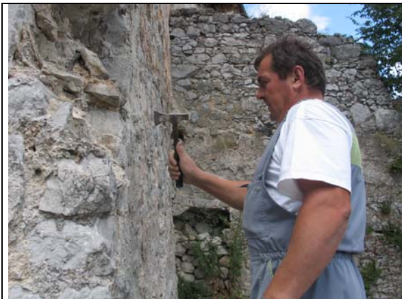
Čiščenje cementnih dodatkov
