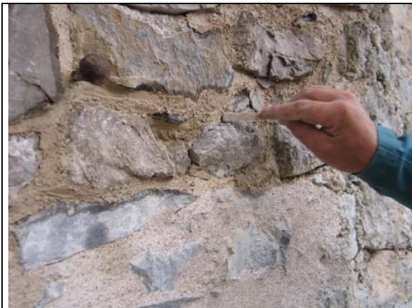
Nanos apnene malte z modelirko v očiščene stike, na mokro podlago
