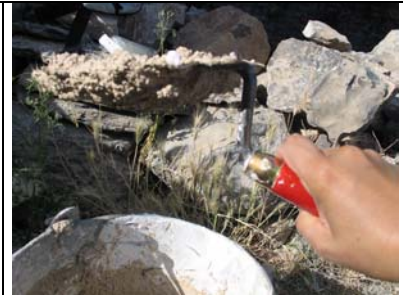
Malta 1:3, mora biti tako mastna, da obstane na obrnjeni žlici.
