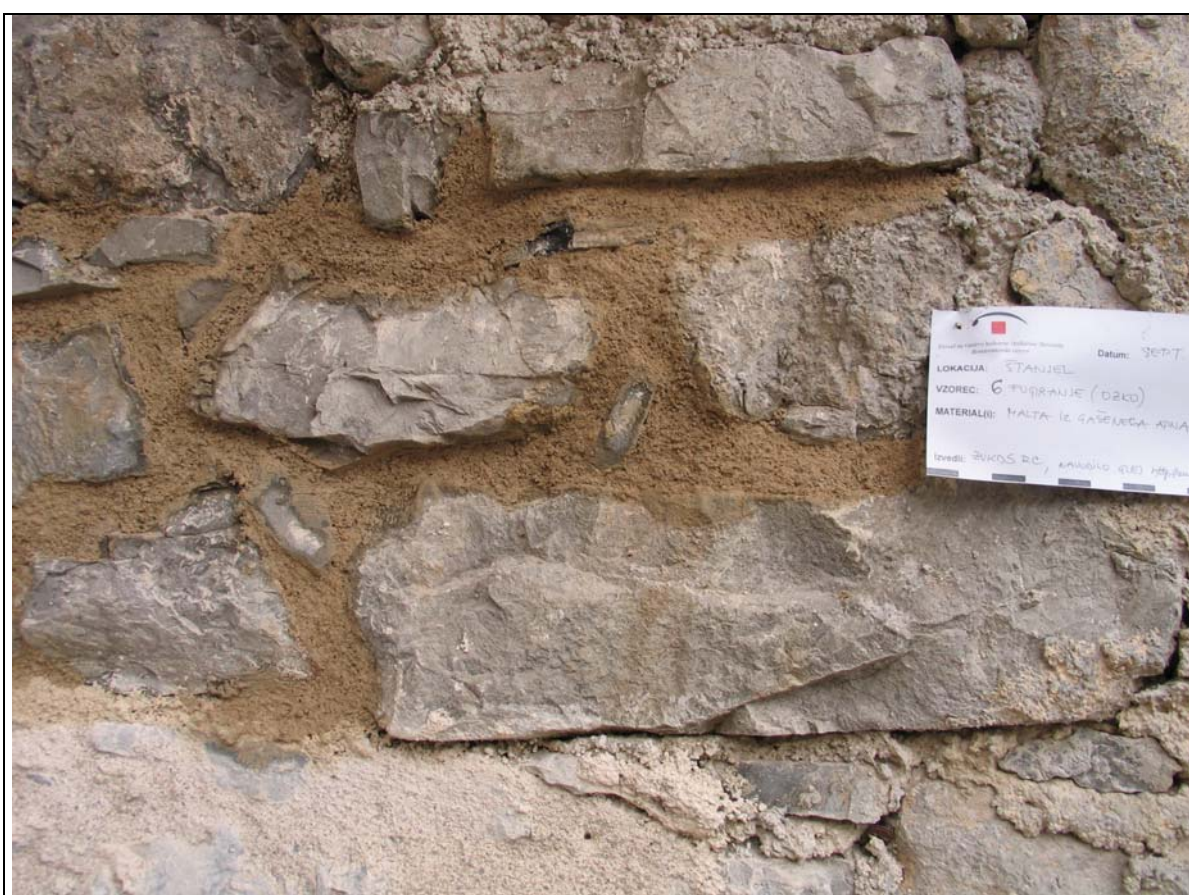
Vzorec izvedbe »ozkega« fugiranja na hiši Markočič, Štanjel
