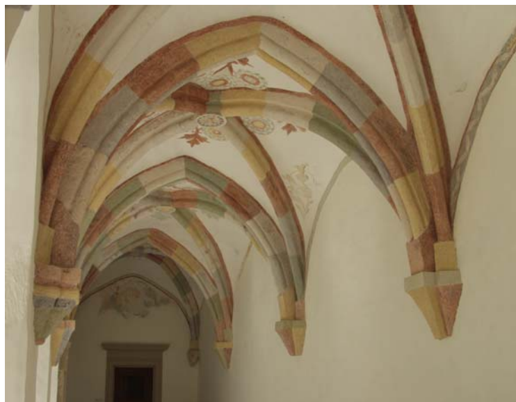
Restavriran strop križnega hodnika
