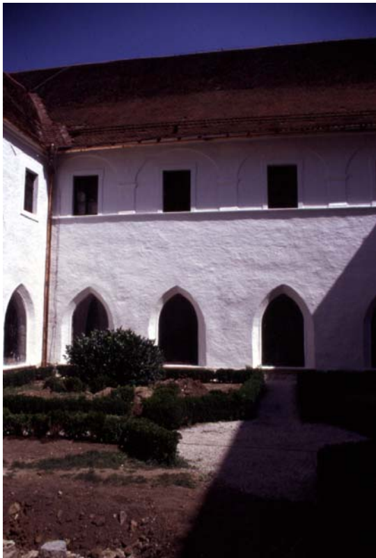
Obnovljene fasade križnega hodnika
