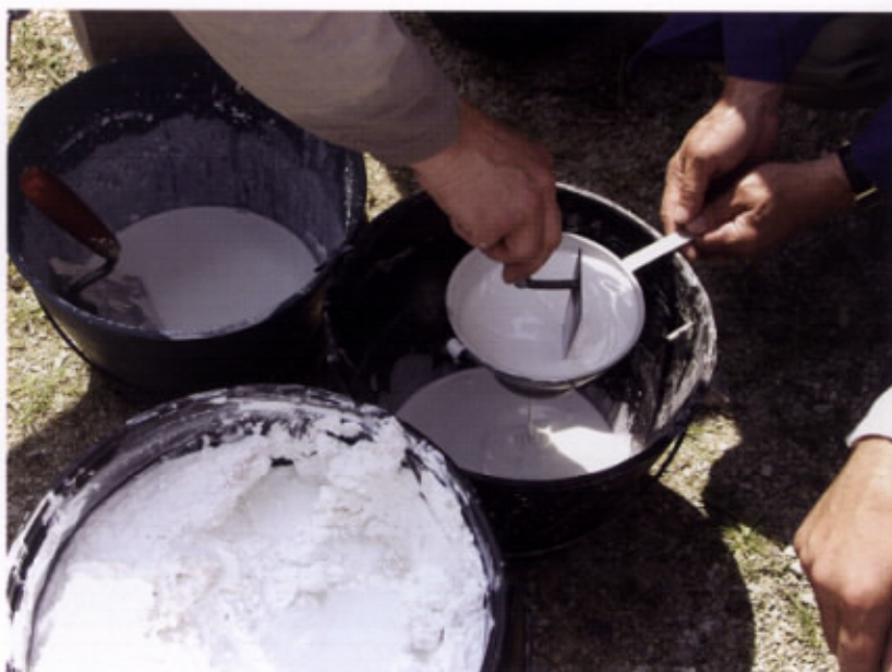
Pasiranje gašenega apna za pripravo injektirne mase, cerkev sv. Luke, Prapreče pri Lukovici
