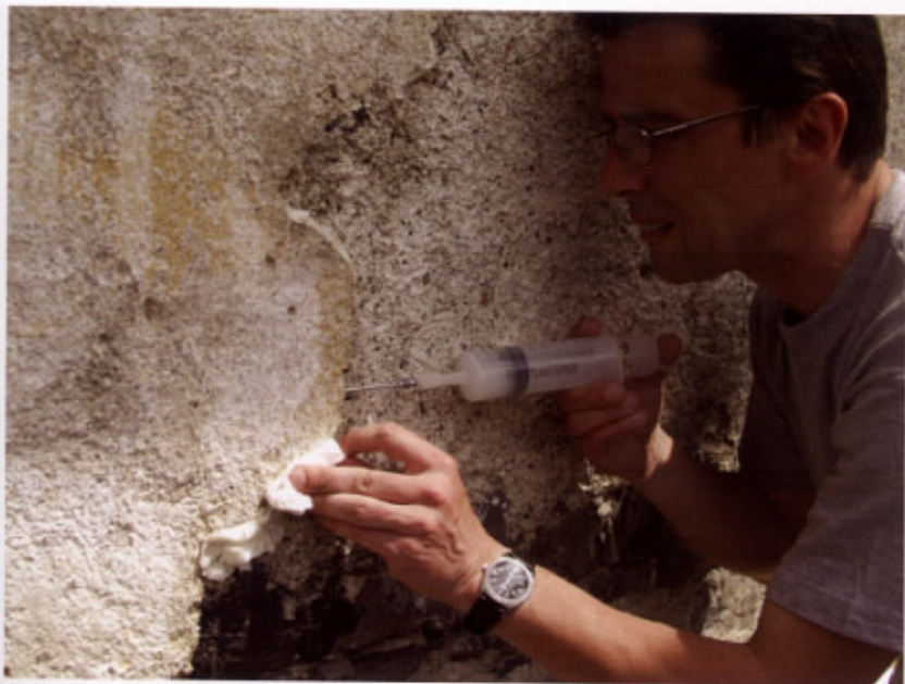
Vbrzgovanje apnene vode in sprotno stičenje robov s papirjem, cerkev sv. Luke, Prapreče pri Lukovici
