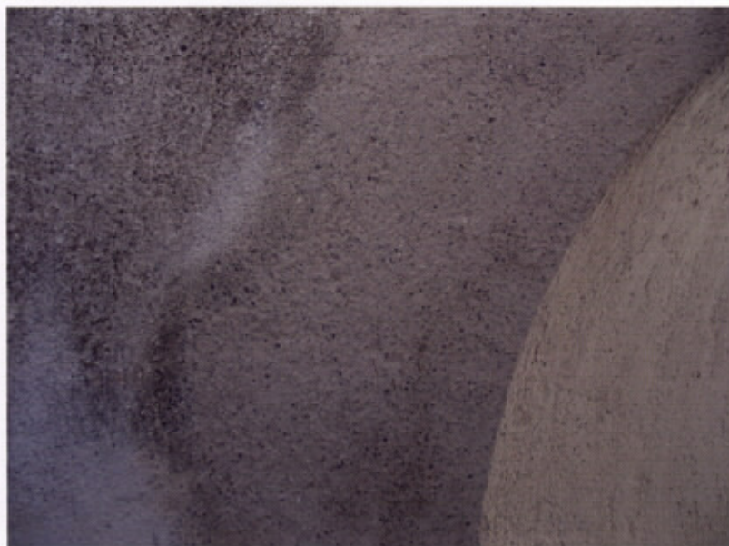
Primer stika med originalnim (levo) in novim (desno) ometom. Približevanje granulaciji in barvi peska ter površinski obdelavi, Paplerjeva hiša v Škofji Loki
