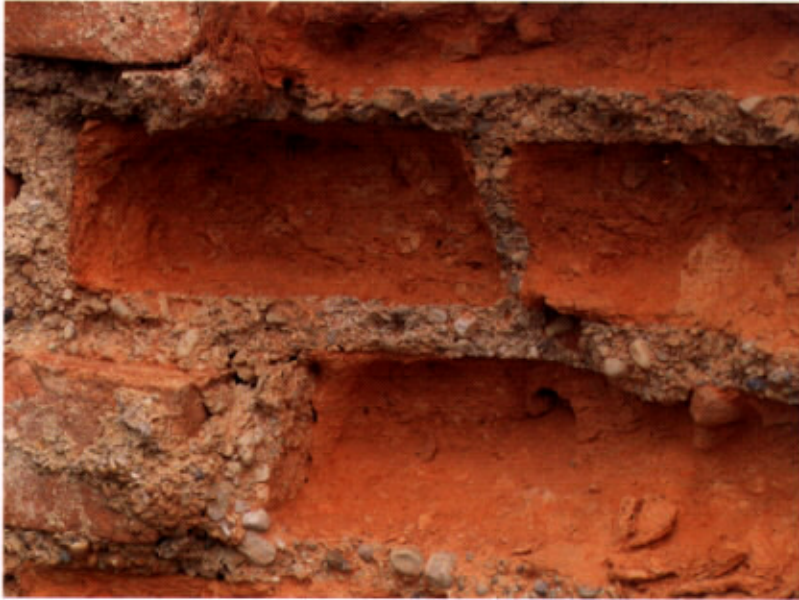
Paronepropustna malta je trdnejša, propada porozno gradivo – opeka. Vse fotografije: Mateja Kavčič
