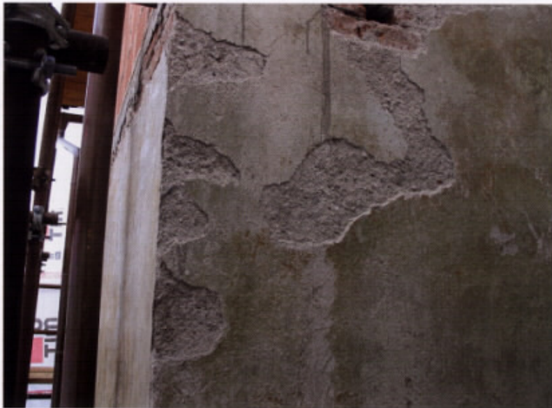
Primer odstranitve zaplat neustreznega ometa, Paplerjeva hiša v Škofji Loki, 2005
