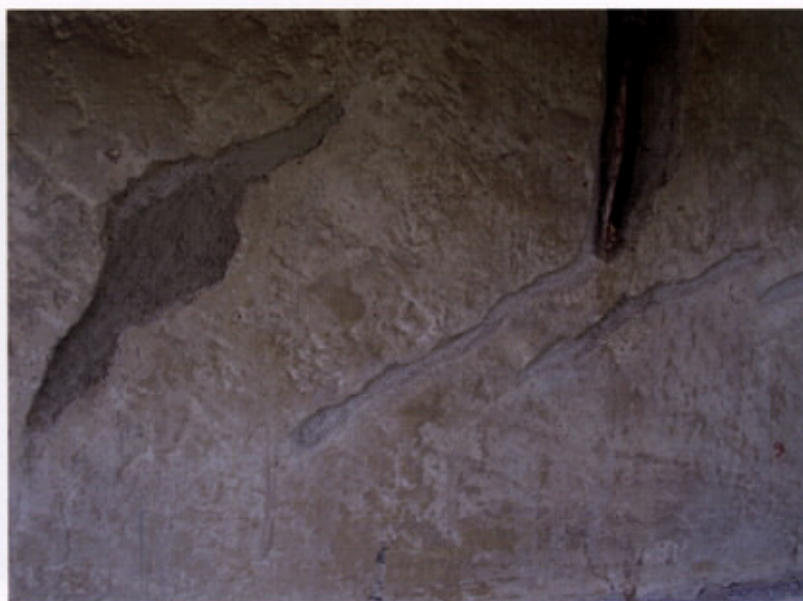
Izdelava nivojskih zaplat apnenega ometa, grad Pišece, 2005
