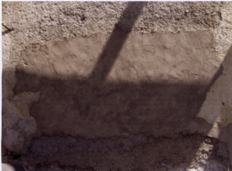
Primer preplastitve s tankim slojem apnenega ometa. Površina je glajena z zidarsko žlico v približek originalnemu ometu, cerkev sv. Luke, Prapreče pri Lukovici, 2003
