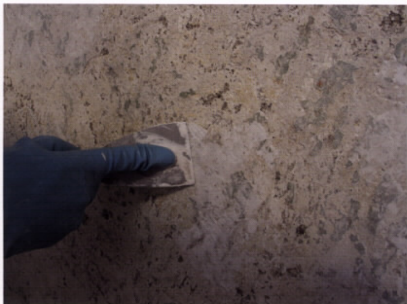
Primer vtiskovanja mase v razpoke, Paplerjeva hiša v Škofji Loki, 2005
