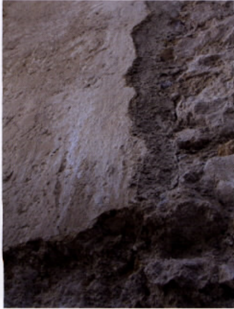
Obšivanje robov originalnega ometa pred izvedbo zaplat, grad Pišece, 2005
