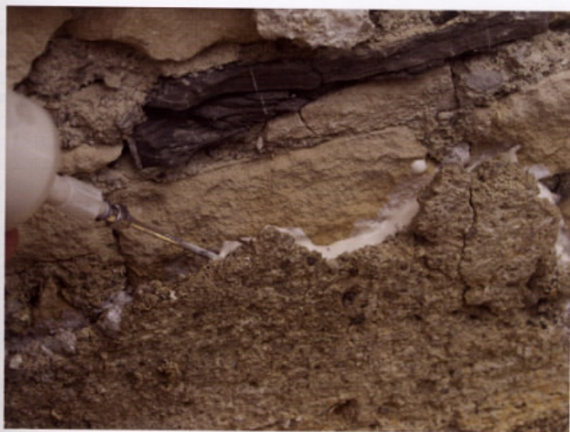
Injektiranje z apneno malto, cerkev sv. Luke, Prapreče pri Lukovici
