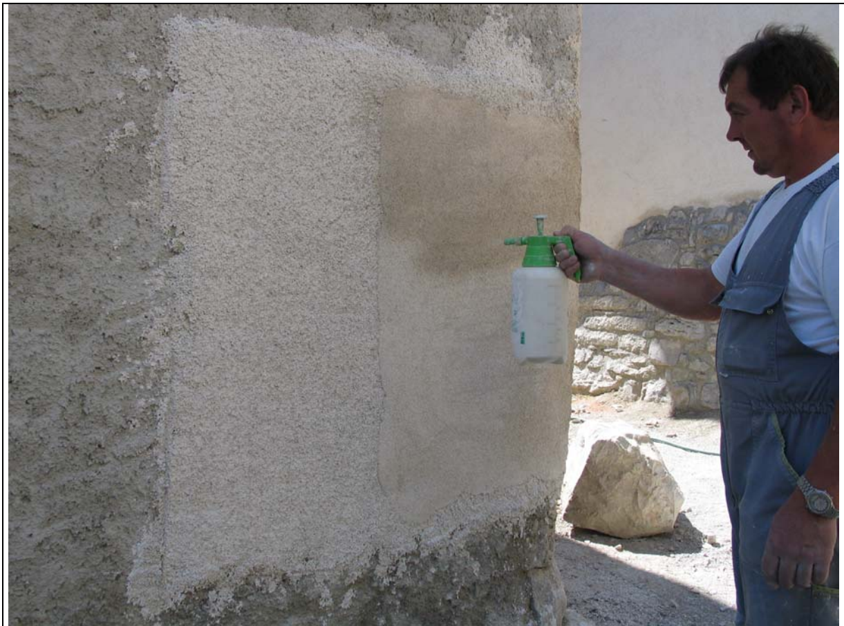
Vzorec fino zaribanega apnenega ometa, fasada hiše Furlan, Štanjel 8 (vlaženje med sušenjem)
